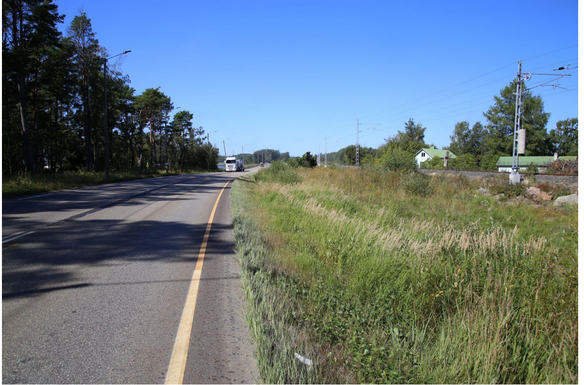
Näkymä kohti Kappelinsalmea. Suunniteltu JKPP-väylä sijoittuu maantien ja radan välialueelle.
