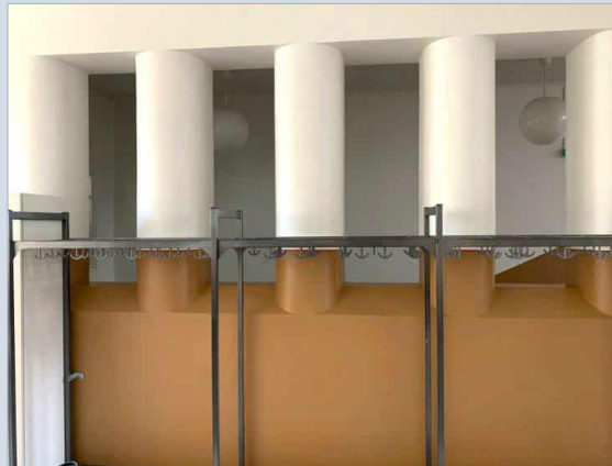
Rajaava, muurattu rakenne luokka-aulan ja pääportaikon välissä.
