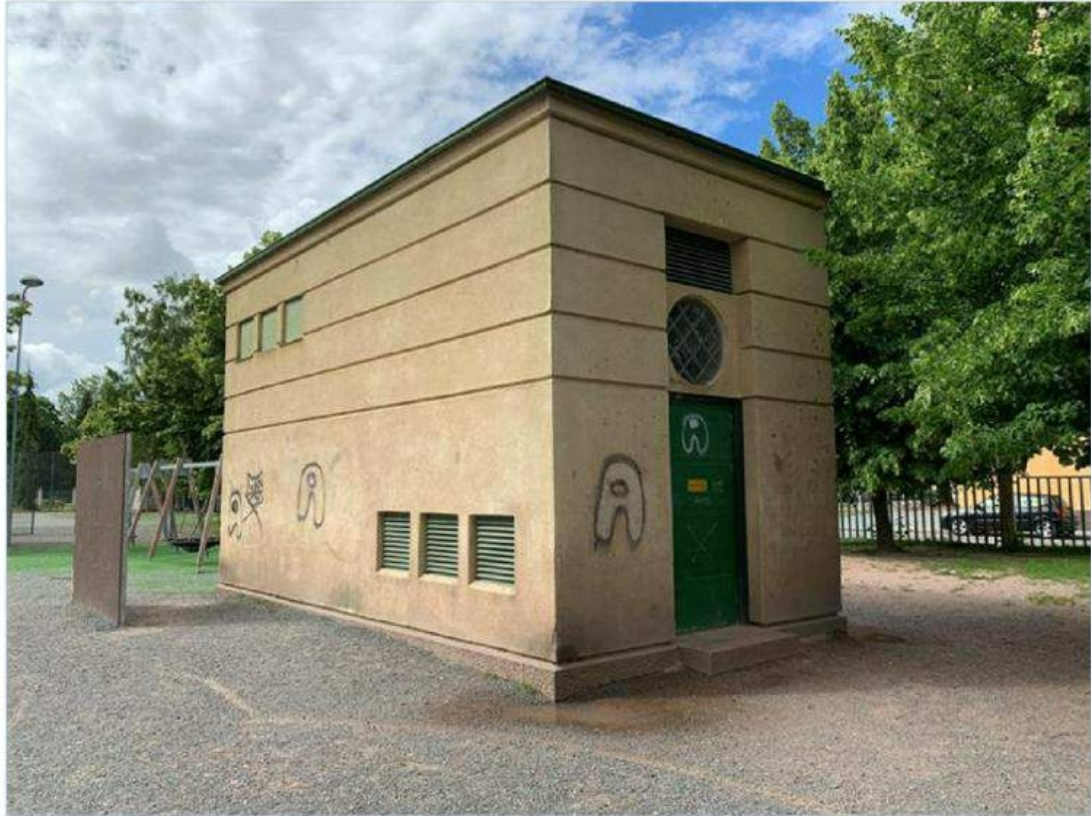
Kuva 5 Muuntamo -rakennus (Kuva: Helene Kaarnametsä, 2023)
