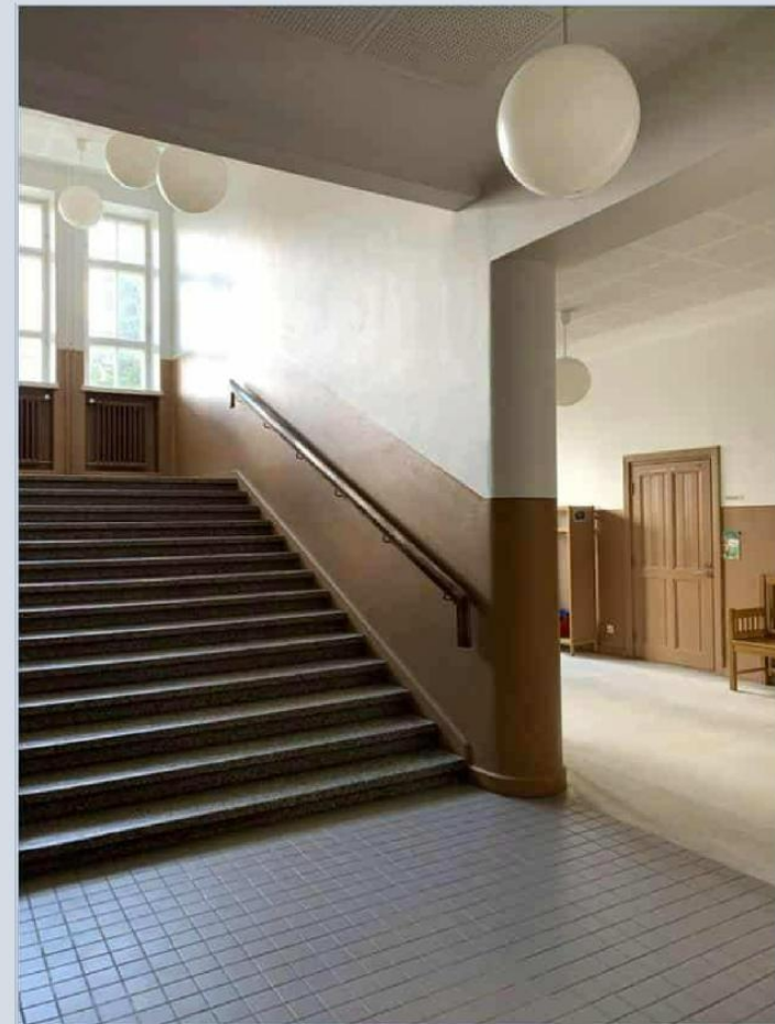
Portaat toiseen kerrokseen. Oikealla itäinen luokka-aula.
