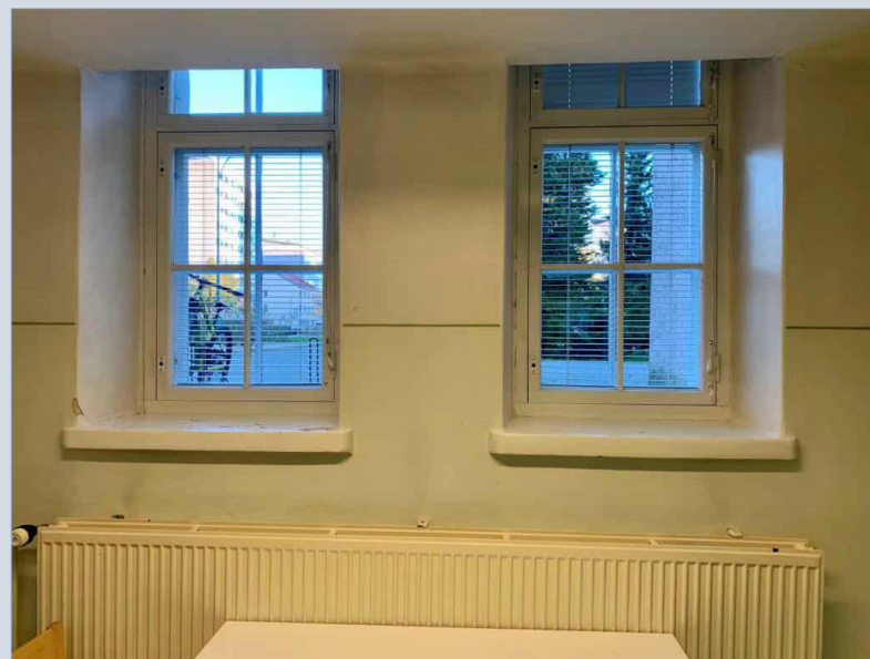
Myös kellarikerroksen ikkunoihin liittyvät kiinteät ikkunapenkit.
