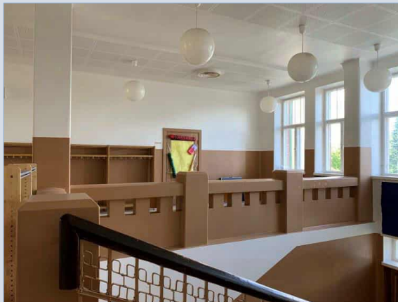
Portaikkoa ja luokka-aulaa rajaa muurattu kaide.
