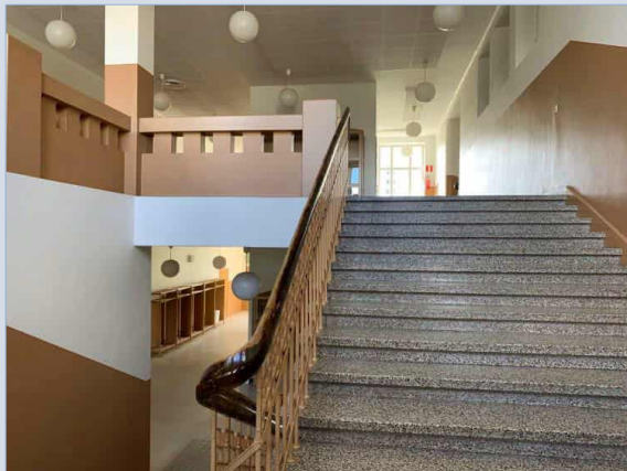
Pääportaikko toisen ja kolmannen kerroksen välissä.
