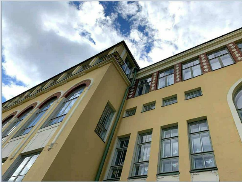
Pohjoisjulkisivua koristavat monimuotoiset ikkunat, punatiilikoristeet ja rappausornamentit.
