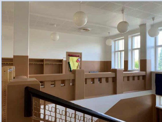
Portaikkoa ja luokka-aulaa rajaa muurattu kaide.
