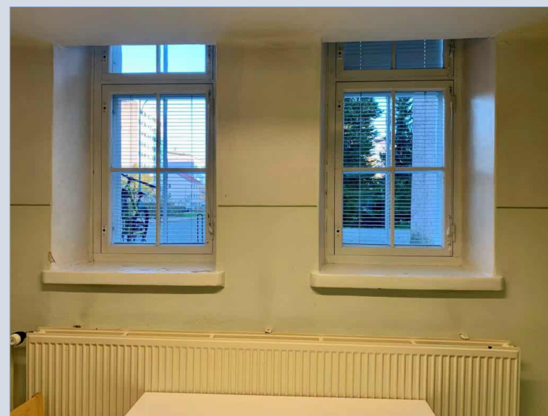
Myös kellarikerroksen ikkunoihin liittyvät kiinteät ikkunapenkit.
