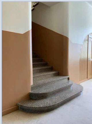
Mosaiikkibetonipintaiset portaat toisen kerroksen luokka-aulasta välikerrokseen.
