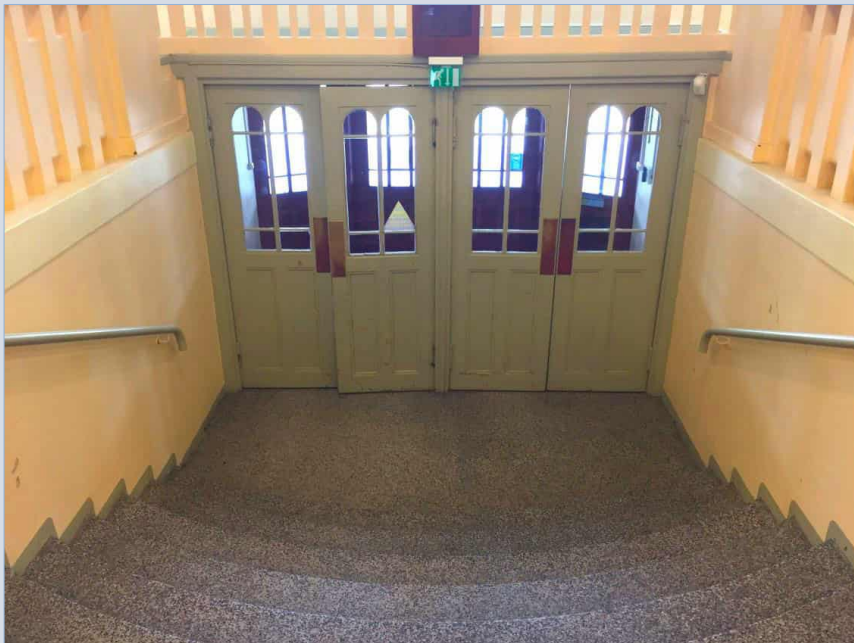
Sisäänkäynnin puuovet ja kaarevat mosaiikkibetoniaskelmat.
