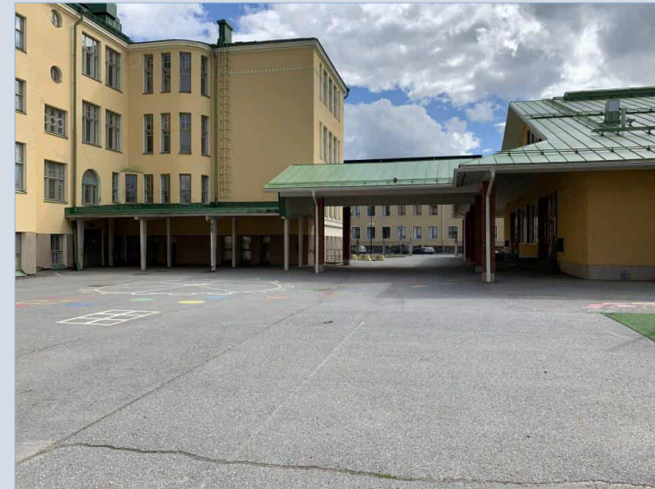
Uusi katoksen osa (oikealla) on alkuperäistä katosta (vasemmalla) korkeampi.
