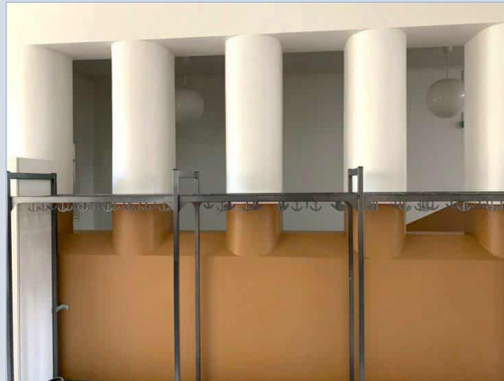
Rajaava, muurattu rakenne luokka-aulan ja pääportaikon välissä.
