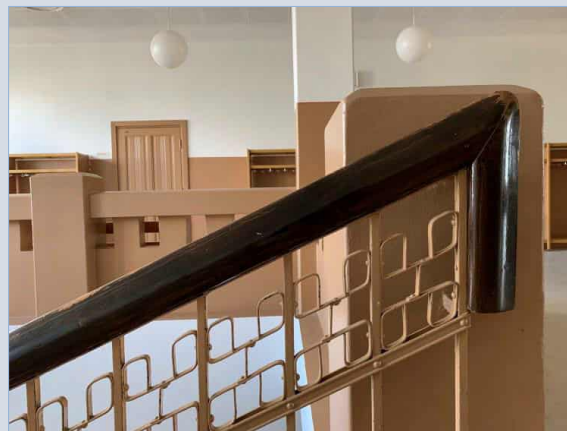
Puinen käsijohde on kiinnitetty koristeelliseen metallikaiteeseen.
