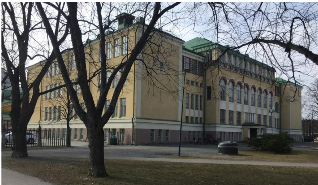
Kuva 7 Cygnaeuksen koulun pohjoinen julkisivu v. 2020. Helene Kaarnametsä
