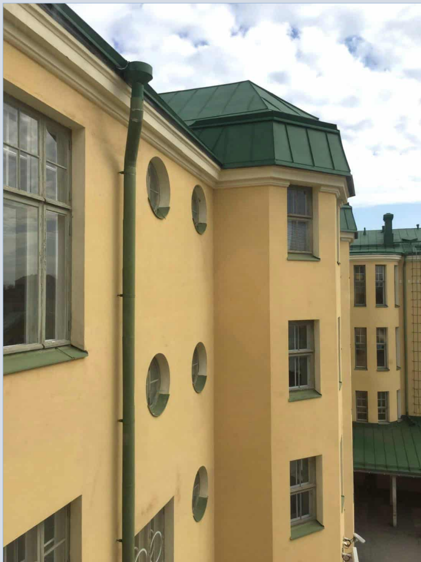
Koulurakennuksen pihajulkisivua erkereineen.
