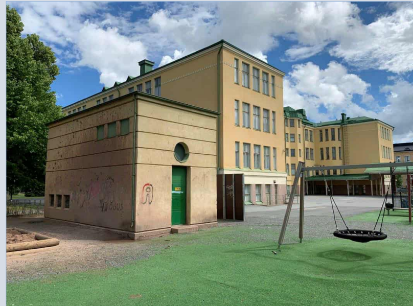
Muuntamo ja koulurakennus.
