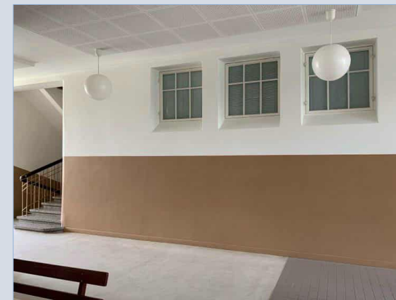
Jykevä väliseinä luokkakäytävän ja taideaineluokat sisältävän rakennuksen keskiosan välissä.
