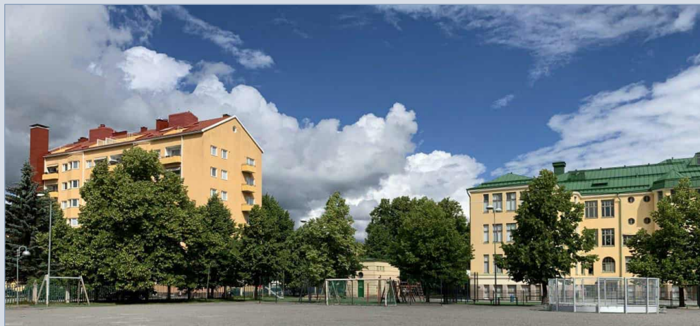
Riihikedon kerroksellista, laadukasta arkkitehtuuria: Rakennusmestarien talo (1953) ja Cygnaeuksen koulu (1912).
