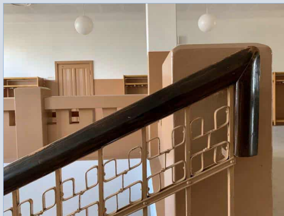
Puinen käsijohde on kiinnitetty koristeelliseen metallikaiteeseen.
