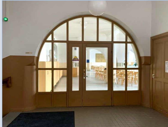
Keskusaulaan johtava aukko, jonka ovi on myöhäisempää perua.
