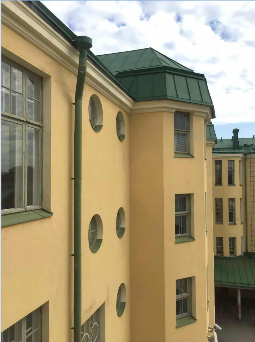
Koulurakennuksen pihajulkisivua erkereineen.
