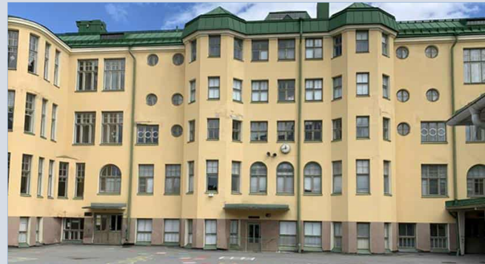
Eri kokoisista ruuduista koostuvilla puuikkunoilla on monia muotoja myös pihajulkisivulla. Aiemmat kaarevat katokset on korvattu tasakatoilla sisäänkäyntien yhteydessä.
