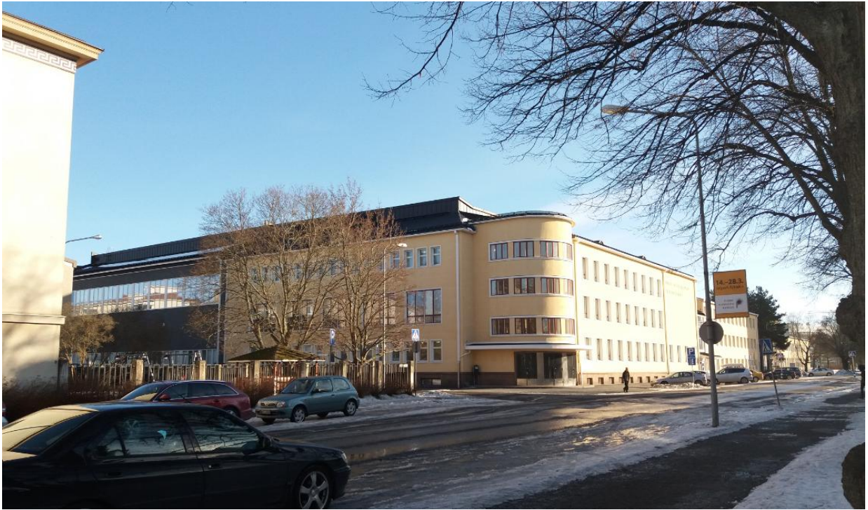
Kuva 8 Peruskorjattu PSYL koulukiinteistö maaliskuussa 2018. Pentti Klemetti
