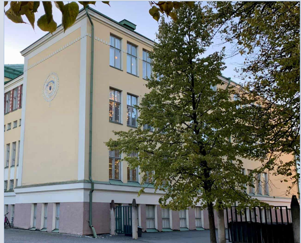
Pääty länteen luoteesta. Kerrosten ikkunat on sommiteltu keskenään symmetrisesti. Ilmeeltään umpinaisessa pohjoisjulkisivun osassa on Porin vaakuna.
