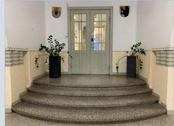
Mosaiikkibetoniaskelmat koulun kansliaan ja opettajainhuoneisiin.
