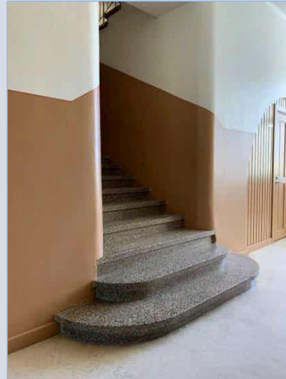
Mosaiikkibetonipintaiset portaat toisen kerroksen luokka-aulasta välikerrokseen.
