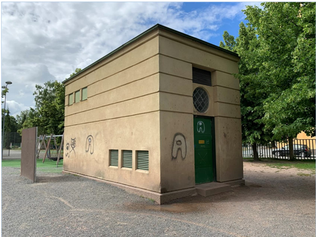
Kuva 6 Muuntamo -rakennus (Kuva: Helene Kaarnametsä, 2023)
