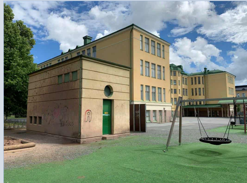
Muuntamo ja koulurakennus.
