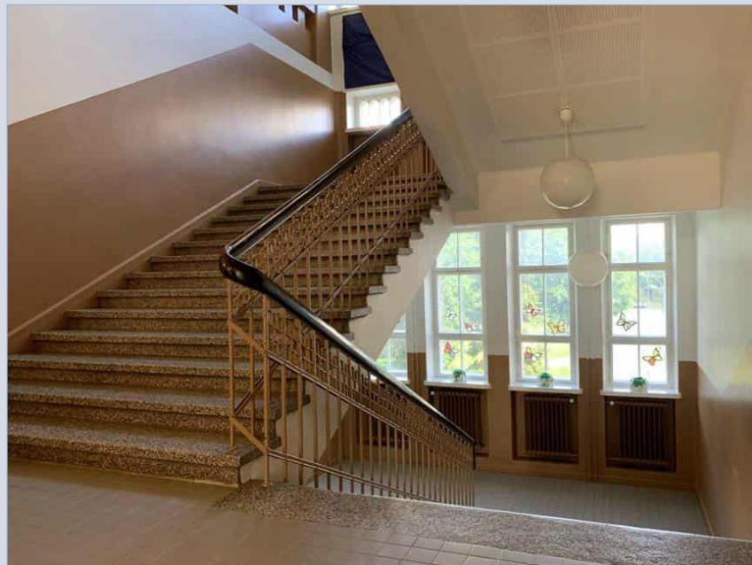
Välitasanteen valurautapatterit sijaitsevat muuratuissa syvennyksissä. Kunkin patterisyvennyksen päällä on kiinteä ikkunapenkki.
