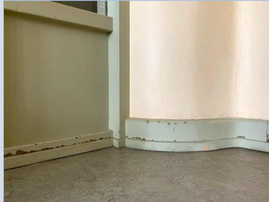
Alkuperäiset leveät, puusta valmistetut lattialistat myötäilevät taidokkaasti tilan kaarevaa muotoa.
