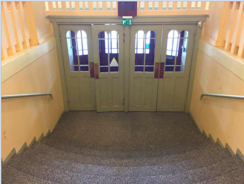
Sisääkäynnin puuovet ja kaarevat mosaiikkibetoniaskelmat.
