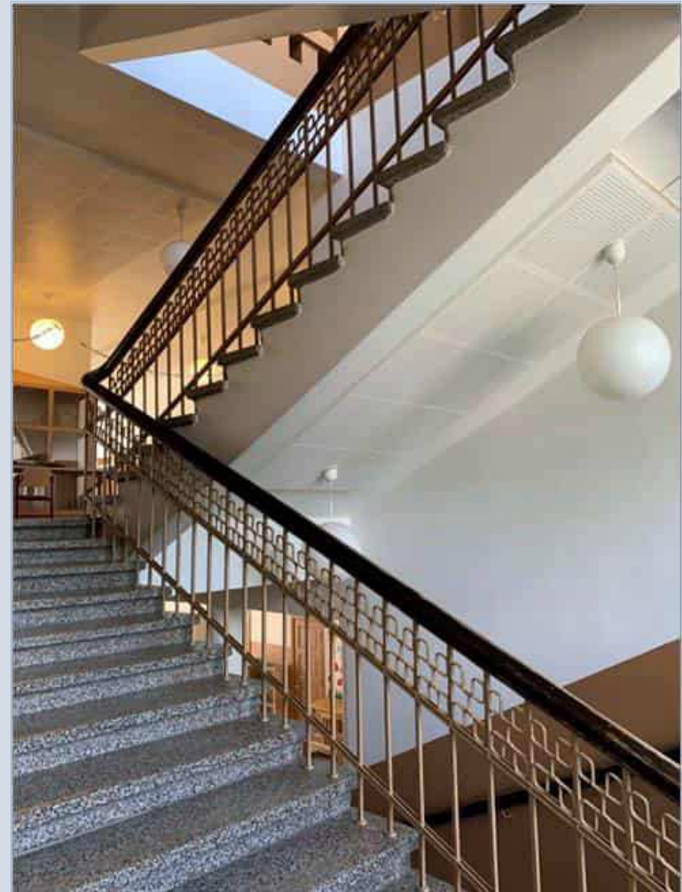
Pääportaikon arvokkaiisiin rakennusosiin kuuluvat mosaiikkibetonipintaiset askelmat, koristeellinen metallikaide ja puinen, lakattu käsijohde.
