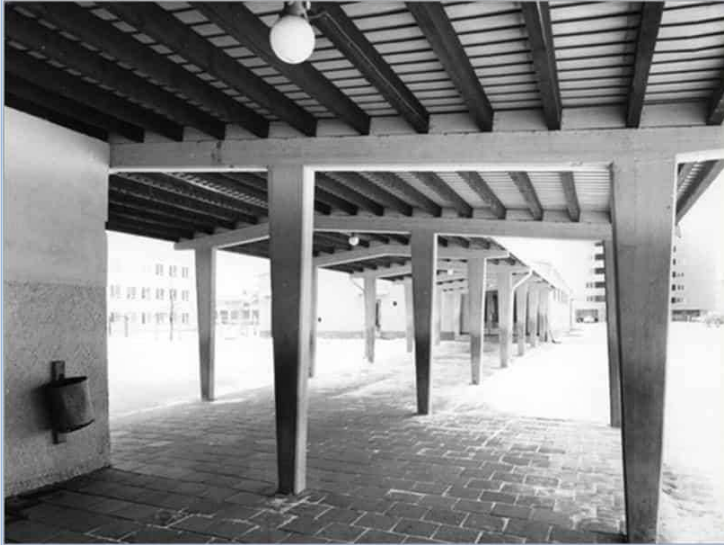
Koulun ja vanhan ruokalan yhdistänyt betonirakenteinen katos. Kuva Sven Raita, Satakunnan Museon kokoelmat.
