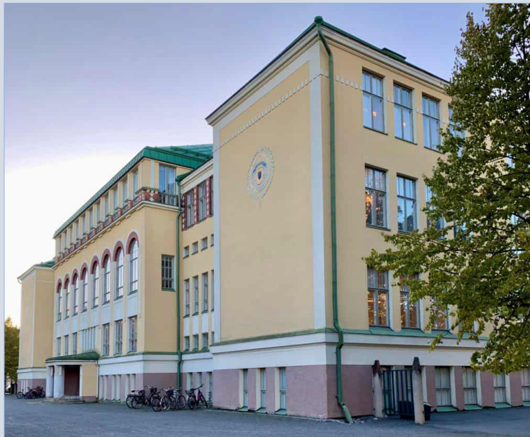
Keskiosaa reunustavat luukkasiivet ovat kellarikerrosta lukuun ottamatta pohjoisivulla aukottomat.
