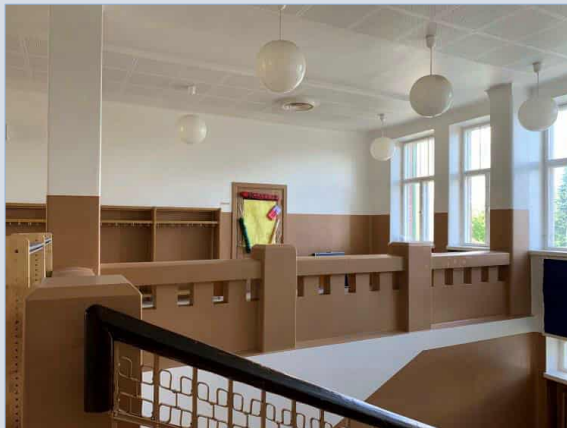
Portaikkoa ja luokka-aulaa rajaa muurattu kaide.
