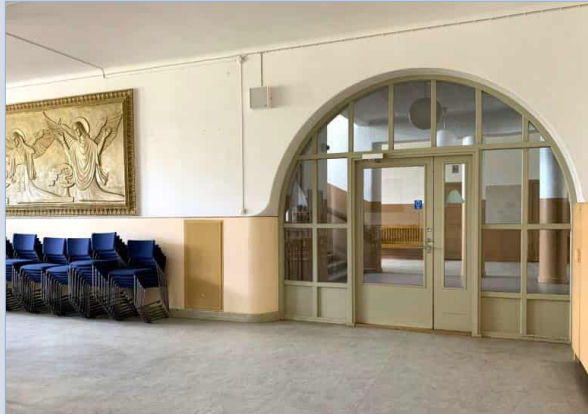
Kaareva ovi- ja ikkunarakenne rajaa aulan itäisestä luokkakäytävästä. Ovet on asennettu jälkikäteen kaaren muotoisiin aukkoihin.
