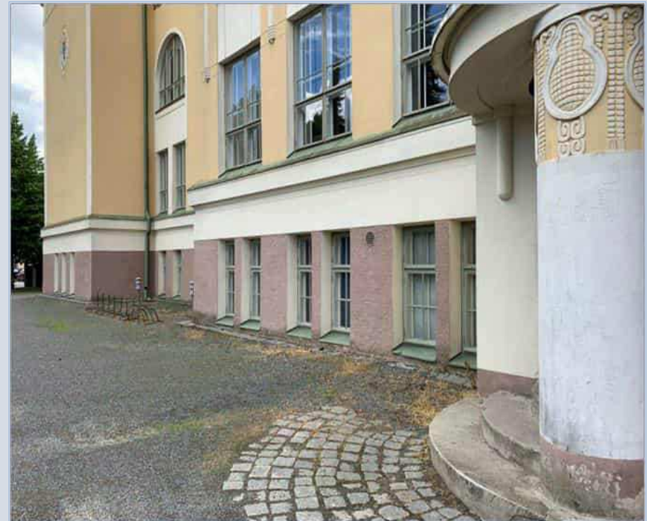
Kellarikerroksen julkisivut poikkeavat muista karkeammalla papurappauksellaan ja värillään. Oikealla pääsisäänkäyntiin liittyvä pylväs.
