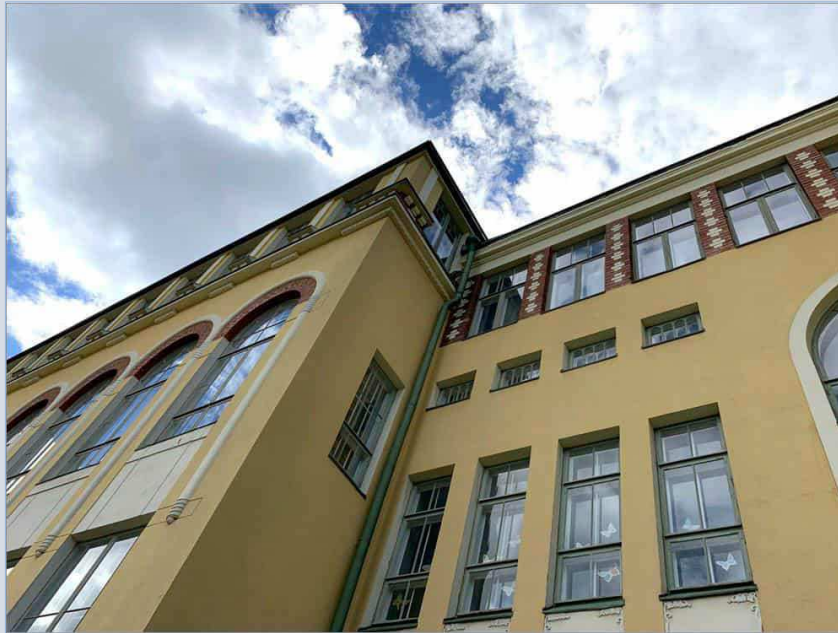
Pohjoisjulkisivua koristavat monimuotoiset ikkunat, punatiilikoristeet ja rappausornamentit.
