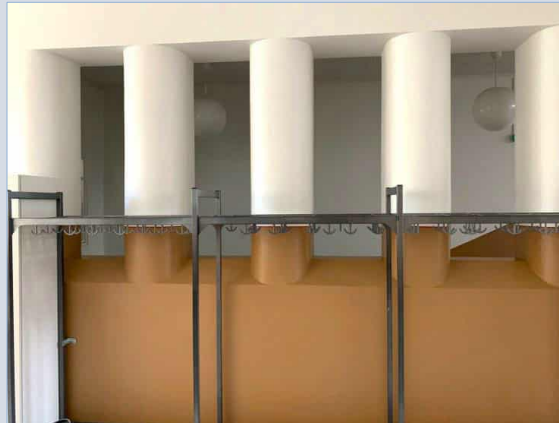
Rajaava, muurattu rakenne luokka-aulan ja pääportaikon välissä.
