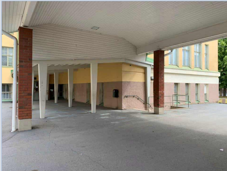
Alkuperäinen, kapenevien betonipilareiden kannattama 1950-luvun katos on säilytetty osittain. Tiilipilarit kuuluvat vuonna 2010 rakennettuun osaan.
