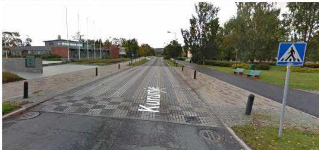
Kuva: Esimerkki leveästä korotetusta suojatiestä Kuruntielle, Ylöjärvellä.
