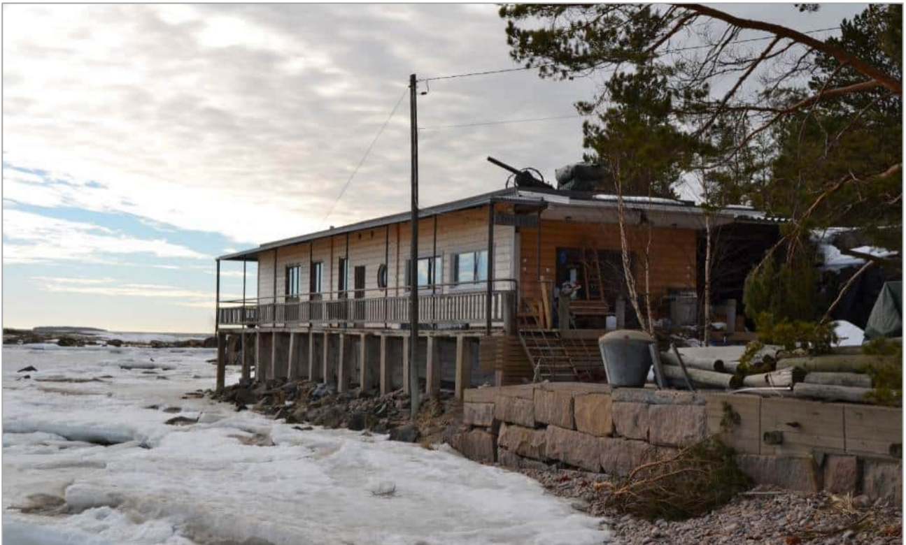
Kuva 46. Entisen öljysataman rakennus Mäntykallon etelärannalla. Kuvannut KT.
