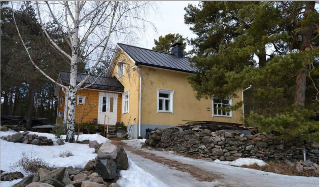
Kuva 47. Entinen öljysatamanhoitajan asuinrakennus maaliskuussa 2022. Kuvannut KT.
