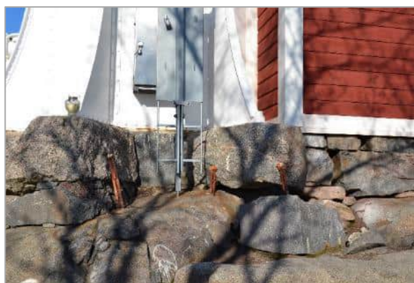
Kuva 24. Majakkatornin perustus on jyhkeää lohkokiveä, asuinosan pienempää luonnonkiveä. Kuvannut KT.
