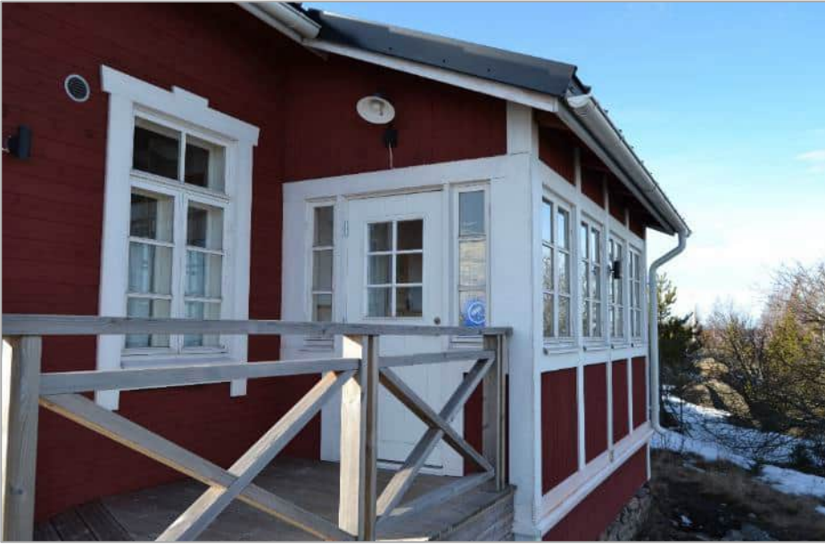
Kuva 38. Luotsivartiotuvan itäsivulla sijaitsee kuisti. Kuvannut KT.
