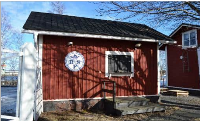
Kuva 31. Vajarakennuksessa on punainen pystyrimavuoraus. Kuvannut KT.
