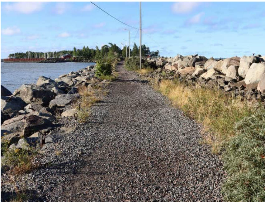
Kuva 5. Aallonmurtaja Kallon pohjoiskärjessä.
