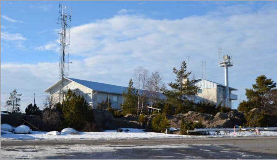
Kuva 44. Merivartioasema kuvattuna sataman puolelta Kallontien yli. Kuvannut KT.
