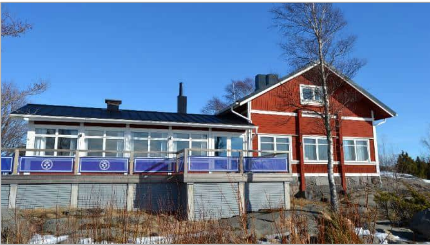
Kuva 28. Paviljongirakennus kuvattuna meren puolelta. Laajennusosan edustalla on betonipaalujen varaan perustettu terassi. Kuvannut KT.
