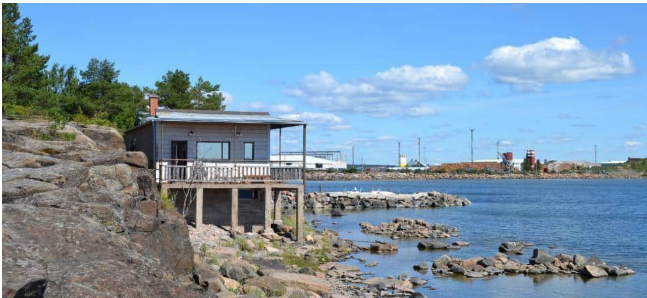
Kuva 48. Entisen öljysataman rakennus kuvattuna etelästä heinäkuussa 2022. Taustalla näkyy Kallon pengertie ja Mäntyluodon satama. Kuvannut KT.
