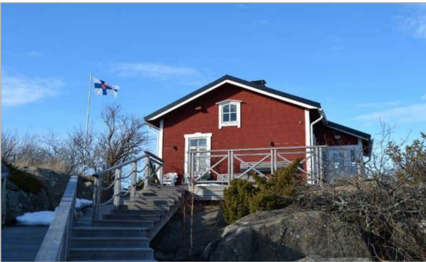
Kuva 37. Luotsivartiotuvan eteläinen pääty. Kuvannut KT.
