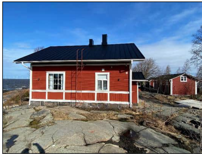
Kuva 21: Luotsivartiotupa sekä pihapiiriin kuuluvia talousrakennuksia.
