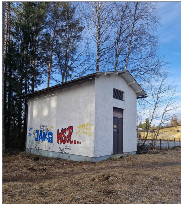
Kuva 6 Kuva suunnittelualueen pohjoisosan puistomuuntamosta. (kuva: Tia Koponen 2.4.2025)
