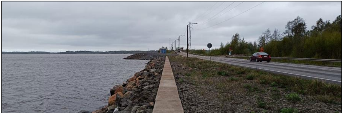
Kuva 13. Reposaaren maantien pengeri, jossa kaapelikanavaa suojaavia laattoja käytetään jalankulun reittinä.
