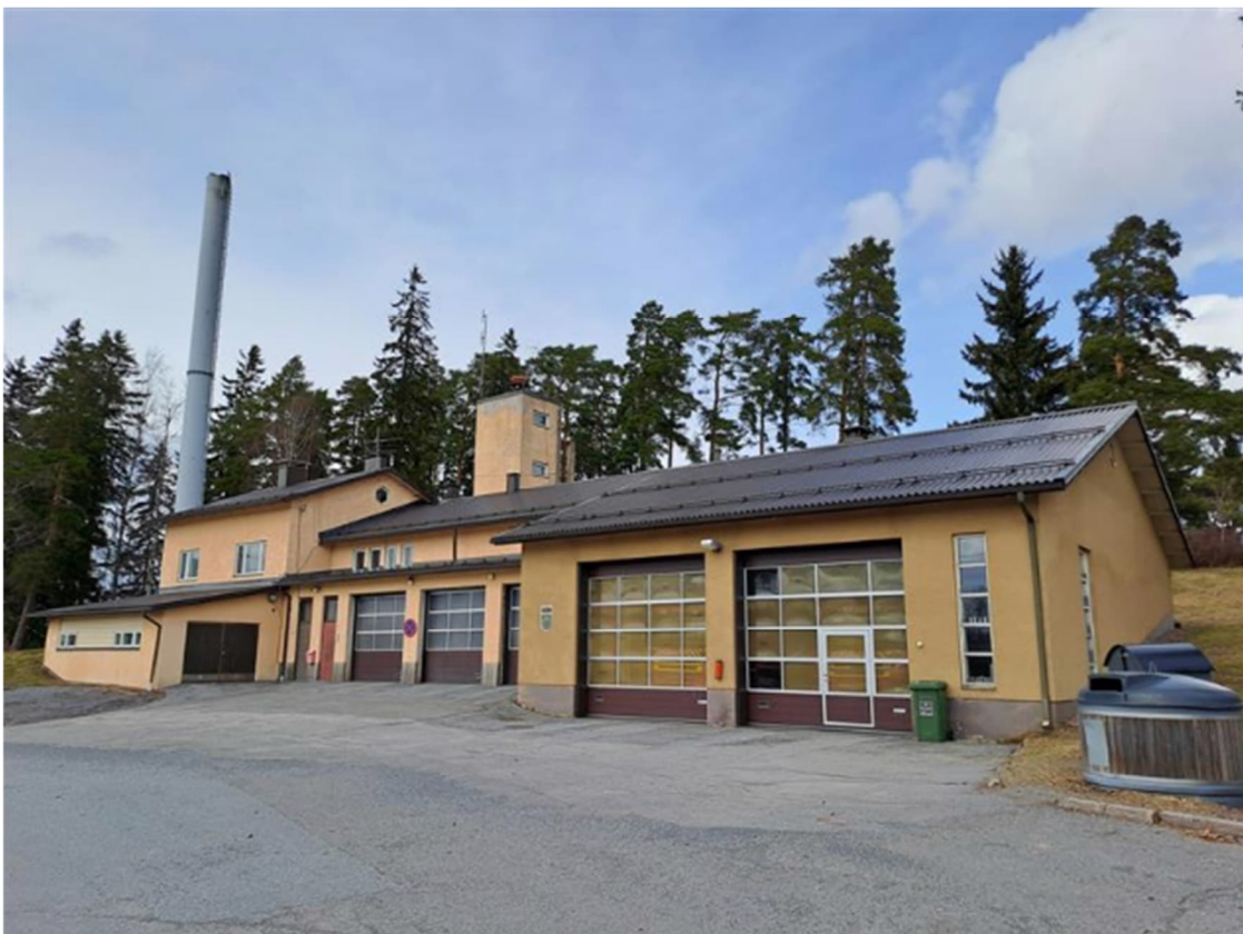
Kuva 8 Paloasema etelästä. (Satakunnan Pakki, Olli Joukio 10.4.2024.)
