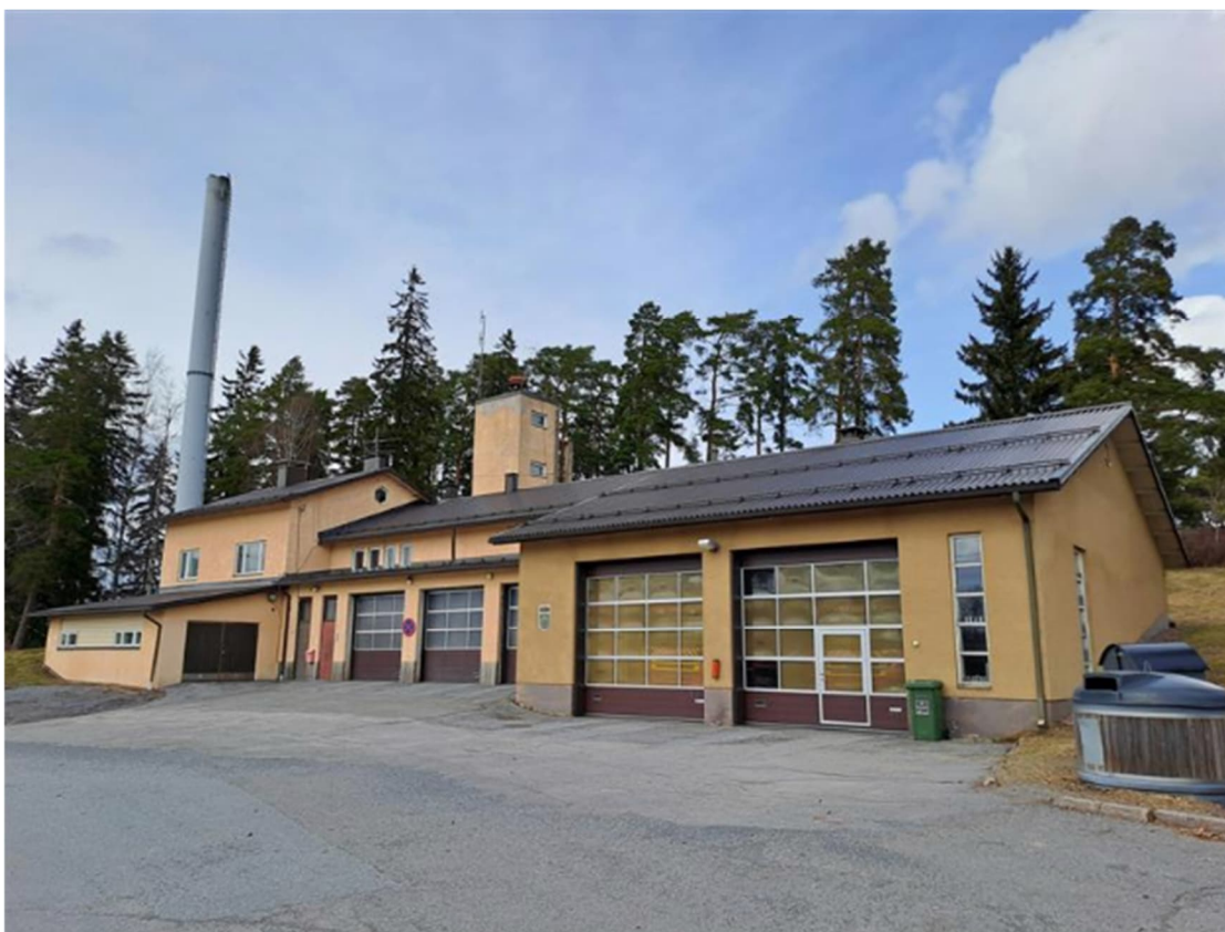
Kuva 8 Paloasema etelästä. (Satakunnan Pakki, Olli Joukio 10.4.2024.)
