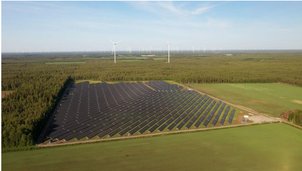
Kuva 11. Kalajoen Juurakon aurinkovoimala. (Solarigo Systems Oy, 2023)
