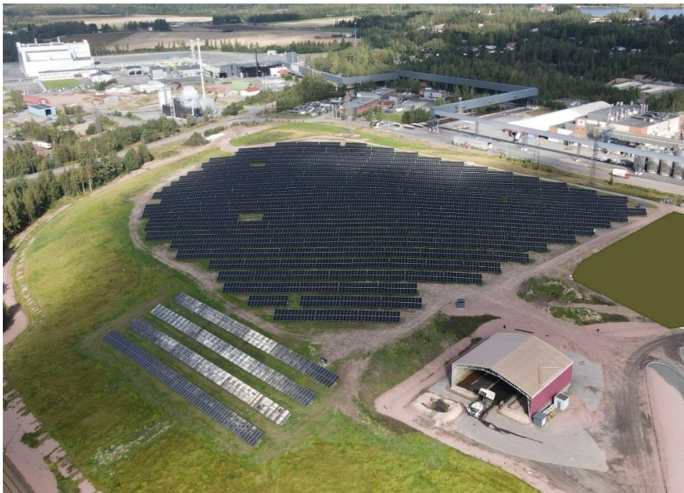
Kuva 12. Harjavaltaan Bolidenin aurinkovoimala-alue.
