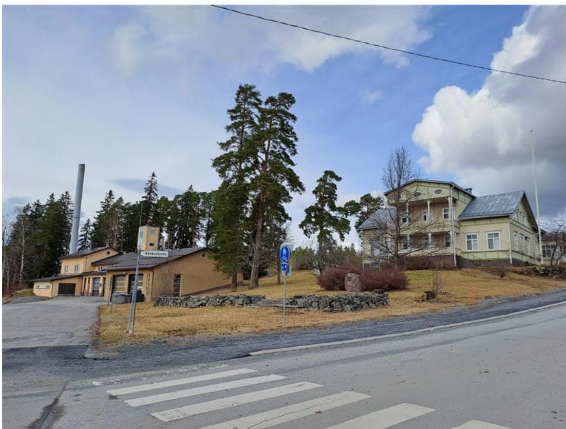
Kuva 1 Paloasema ja ent. kunnantalo etelästä. (Satakunnan Pakki, Olli Joukio 10.4.2024.)
