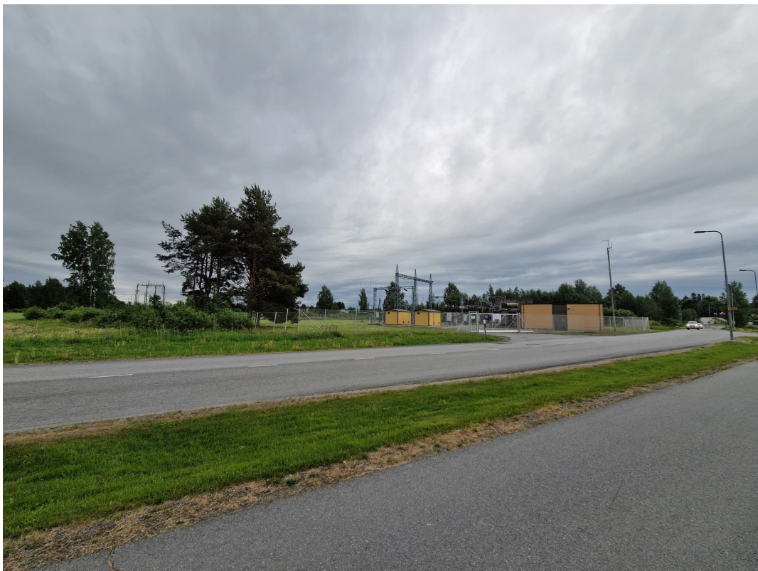
Kuva 2 Sähköasema kuvattuna pohjoisesta. (©Tia Koponen, 6.6.2024)
