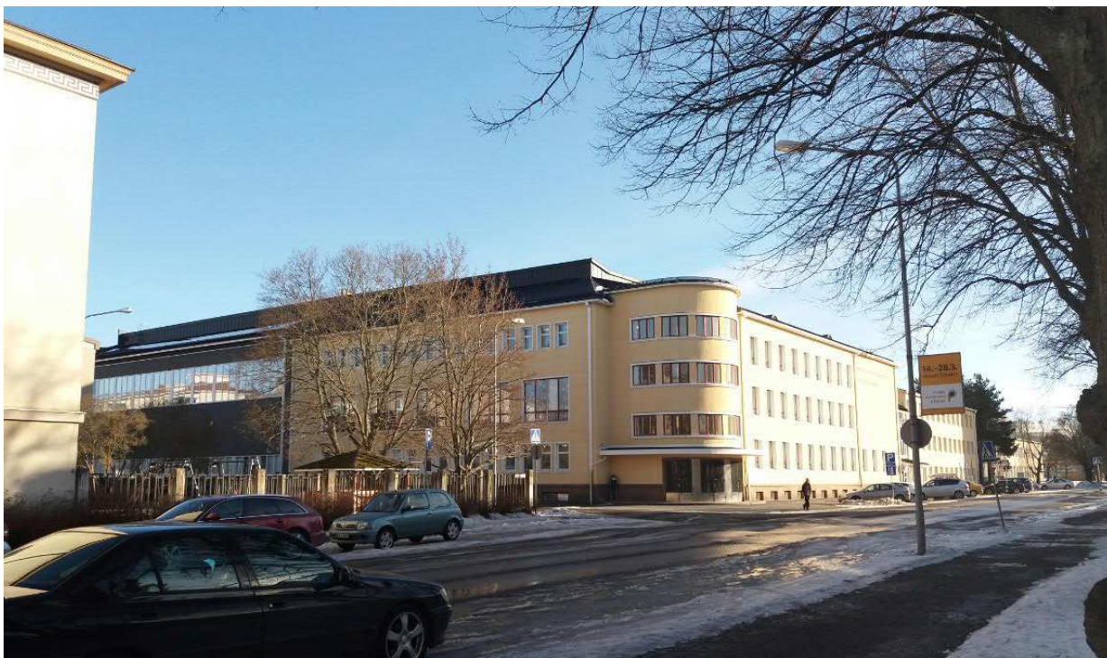
Kuva 8 Peruskorjattu PSYL koulukiinteistö maaliskuussa 2018. Pentti Klemetti
