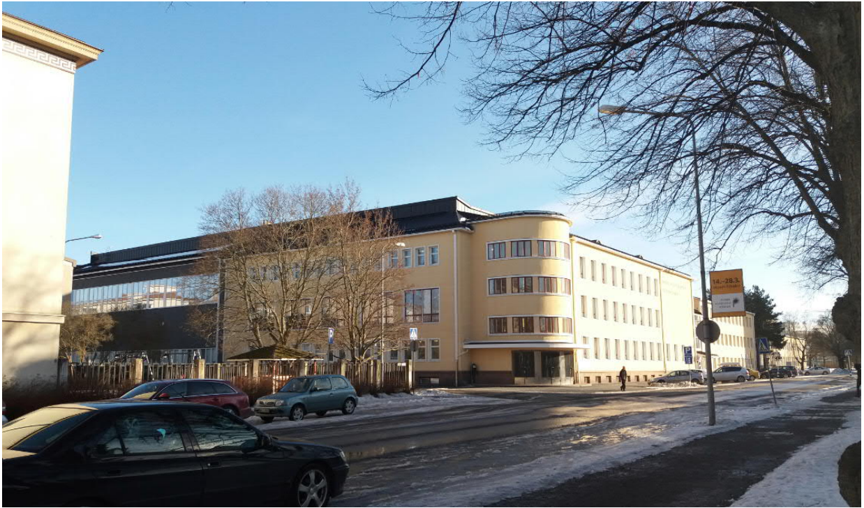
Kuva 8 Peruskorjattu PSYL koulukiinteistö maaliskuussa 2018. Pentti Klemetti
