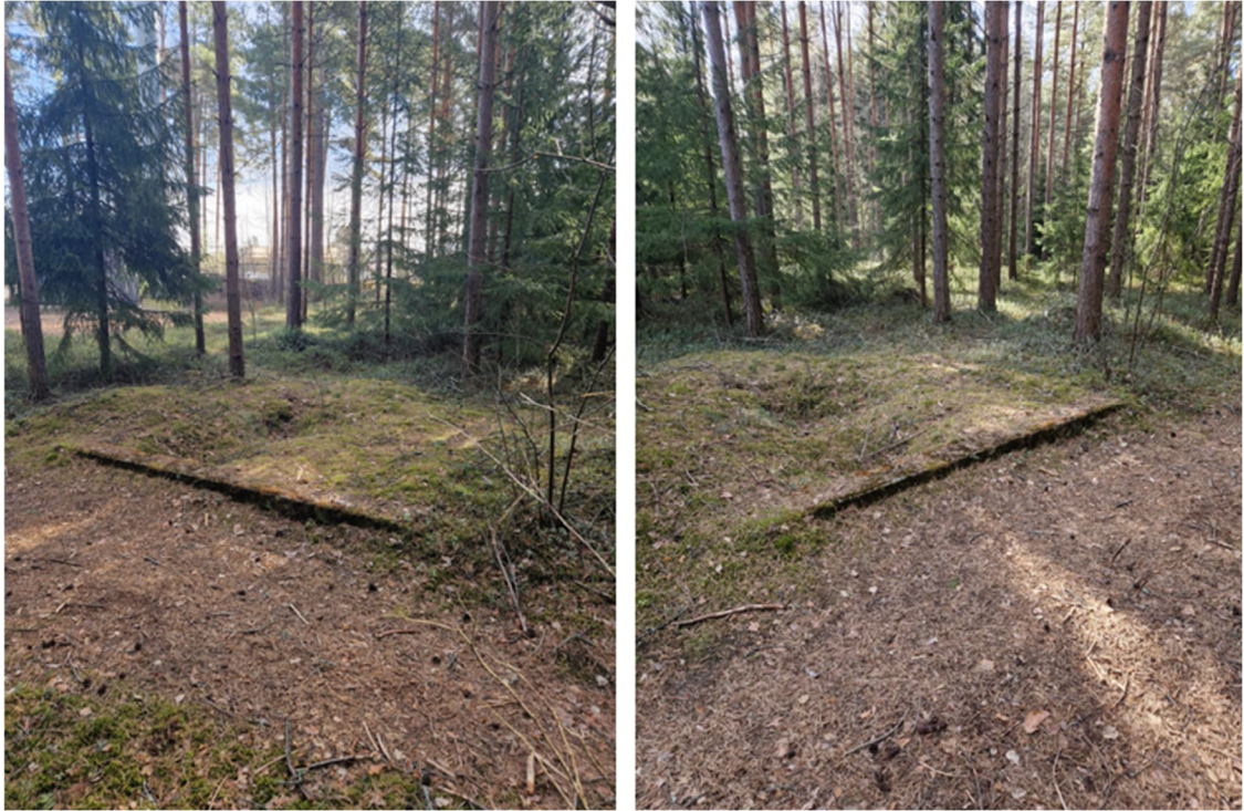
Kuva 7 Kuvat sammaloituneesta kivijalasta. (kuva: Tia Koponen 2.4.2025)
