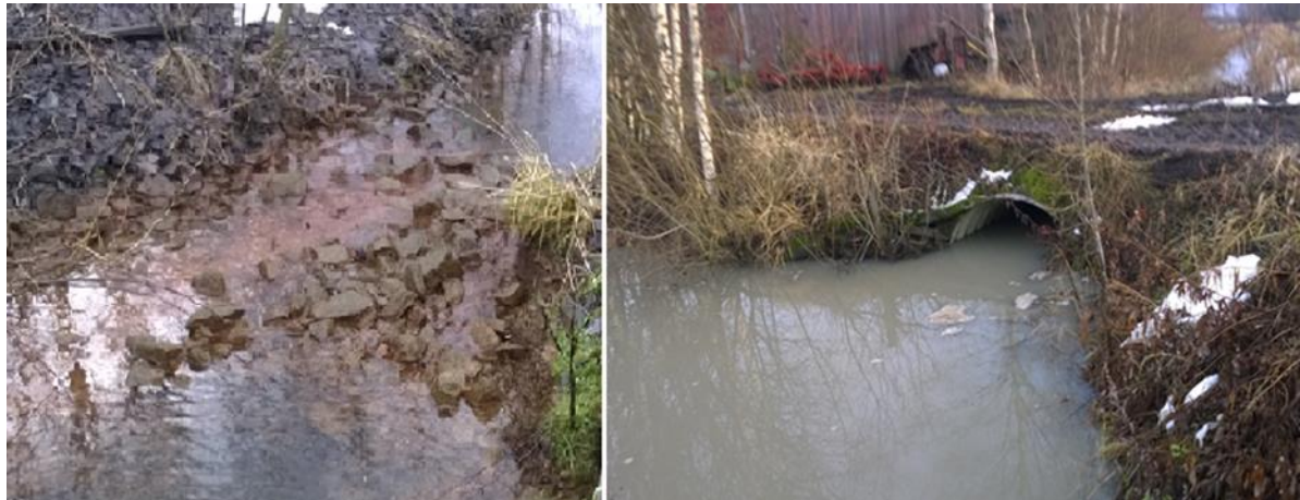
Kuva 3-1. Vasemmalla väritykseltään punertavaa rautasaostumaa. Ojan vesi on myös huomattavan kirkasta, mikä viittaa happamuuteen. Oikealla sementunutta ojavettä. Harmaa kelluva aines on mahdollisesti alumiinisaostumaa, joka johtuu sulfidisavien happamoittavasta vaikutuksesta.
