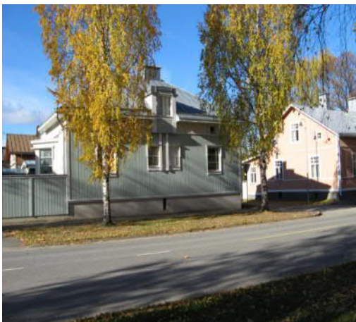
Tässä uudisrakennuksessa ei ole kopioitu vanhaa, mutta materiaalien käyttö, julkisivujen jäsentely ja talon mittakaava ovat onnistunut kokonaisuus. Talo sopii luontevasti osaksi ympäristöään.
