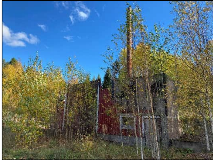
Palanut kuivaamorakennus suunnittelualueen kiinteistöllä 413-408-6-49 KALLIO.
