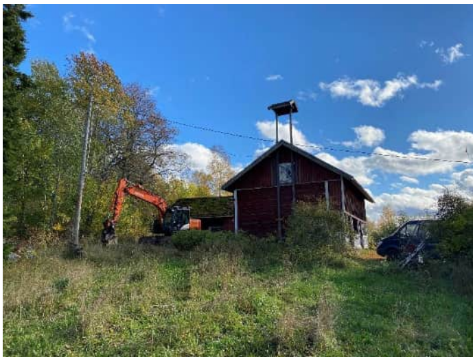
Maatilan talousrakennus kiinteistön 413-408-6-49 alueella.
