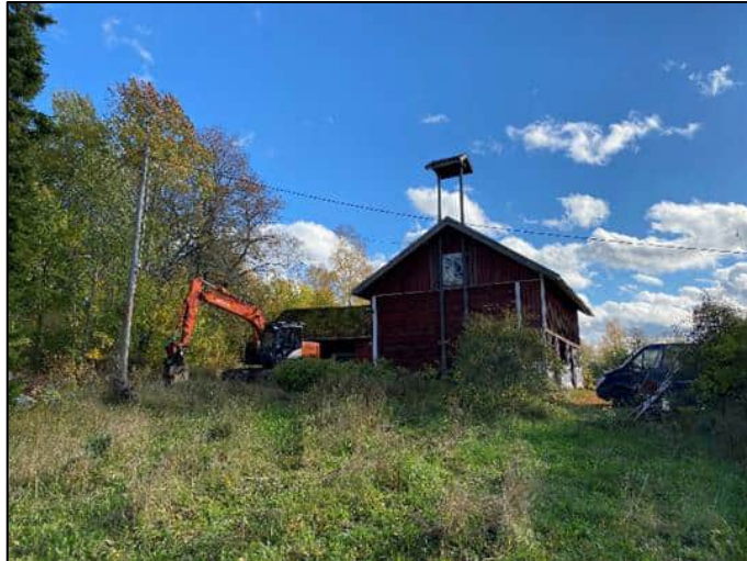
Maatilan talousrakennus kiinteistöllä 413-408-6-49 KALLIO.
