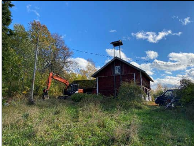
Maatilan talousrakennus kiinteistöllä 413-408-6-49 KALLIO.
