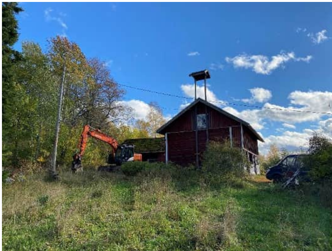
Maatilan talousrakennus kiinteistön 413-408-6-49 alueella.
