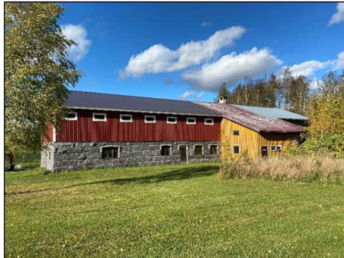
Osin kiinteistön 413-408-6-49 KALLIO alueella sijaitseva vanha navettarakennus.
