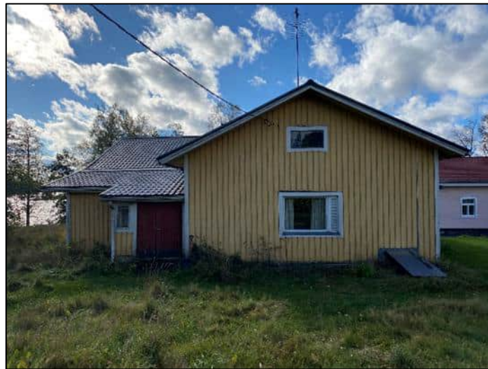
Asuinrakennus suunnittelualueen kiinteistöllä 413-408-6-49 KALLIO. Alueelle on ranta-asemakaavassa tarkoitus osoittaa erillispientalojen rakennuspaikka.
