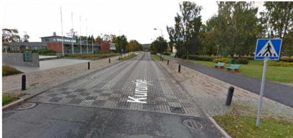
Kuva: Esimerkki leveästä korotetusta suojatiestä Kuruntiellä, Ylöjärvellä.
