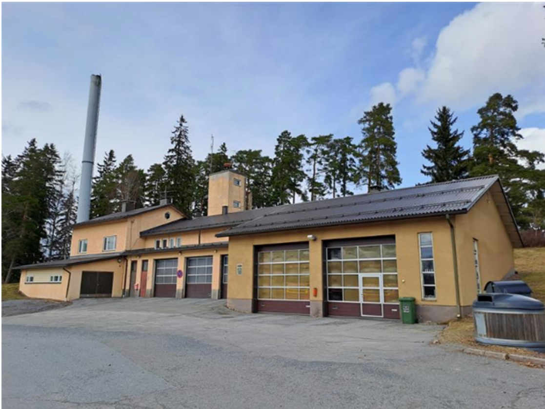
Kuva 8 Paloasema etelästä. (Satakunnan Pakki, Olli Joukio 10.4.2024.)
