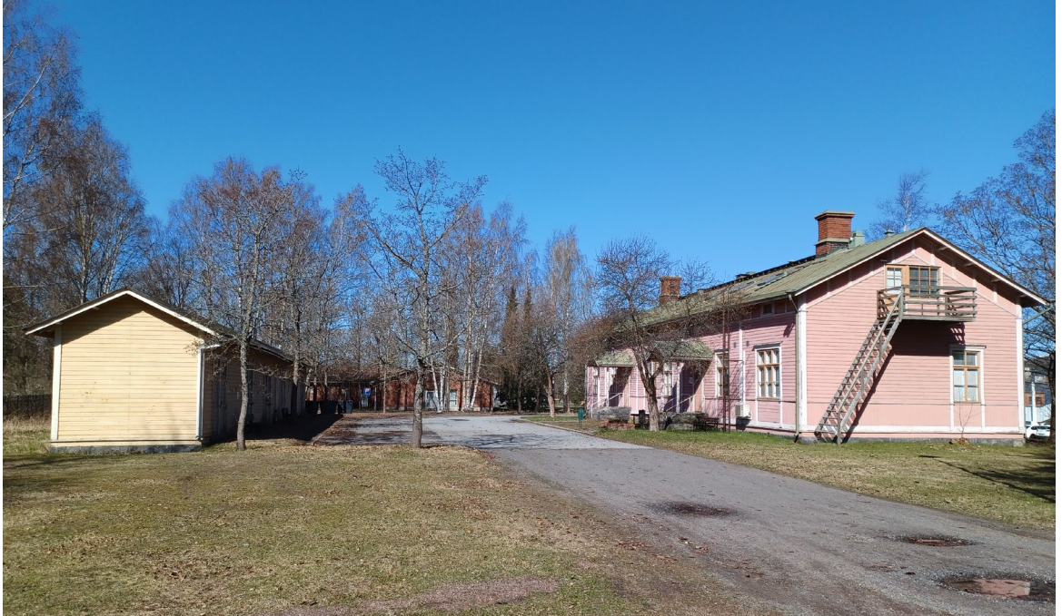
Kuva 2. Suunnittelualueella olevat Porin vanhaan asemakylään kuuluvat rakennukset.
