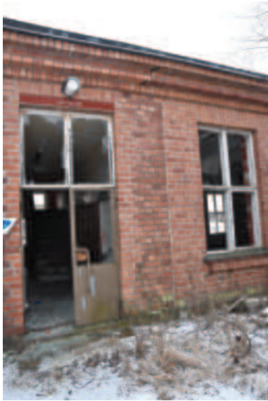
Ammattikoulua varten tehty laajennusosa näkyy tiilisaumana pitkällä julkisivuilla. Laajennus noudattaa alkuperäisen rakennuksen muotokieltä.
