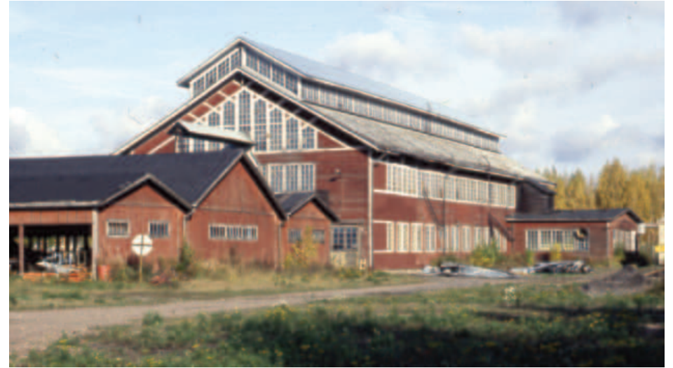
Saharakennus 6.10.1999 korjauksen jälkeen. 1930-luvun siipiosa on purettu. Länsipuolella ollut varastorakennus on vielä paikallaan. Kuva Minna Linnala, SMK.
