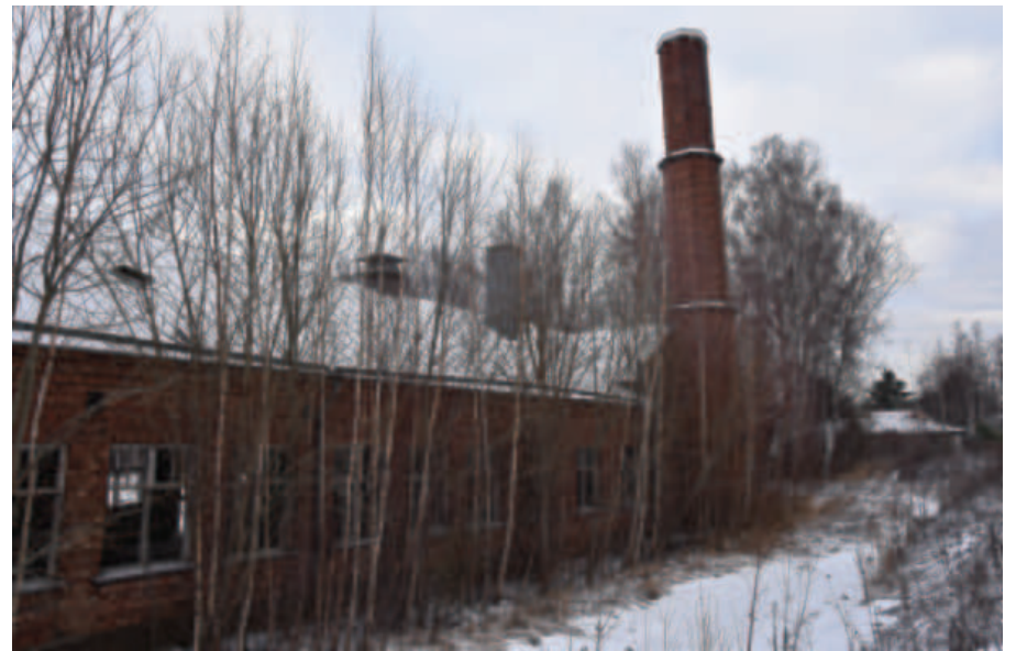
Joen puoleinen julkisivu ja lyhennetty kattilahuoneen piippu.
