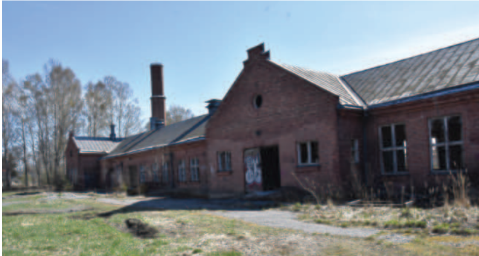
Taloustrakennuksen tien puoleinen julkisivu.
