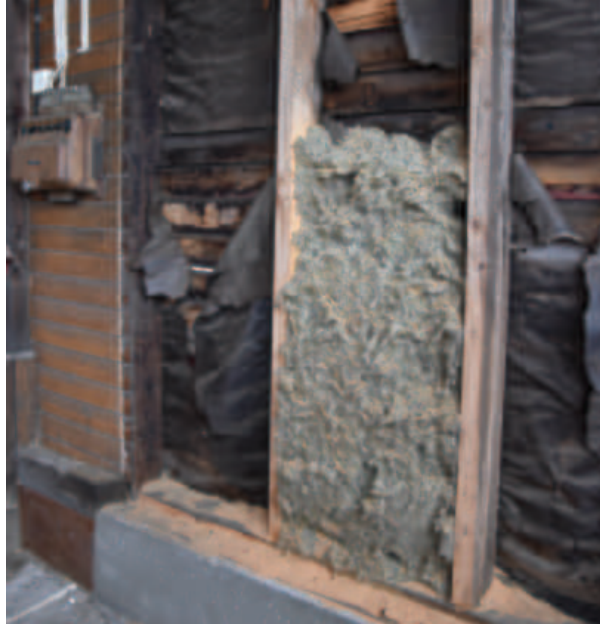
Seinä on rankorakenteinen. Täytteenä on ollut alkujaan sahanpuru, mutta sitä on täydennetty myöhemmin mineraalivillalla.
