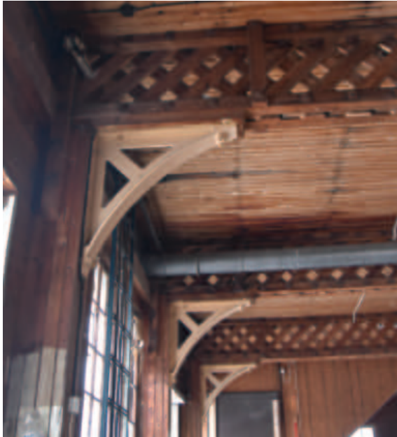
Välipohjan kannatusristikoiden tuentaa ulkoseinän pilareihin.
