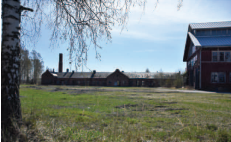
Tukkialtaan paikka on nykyisin täyttömaata ja tukkisillat on purettu.
