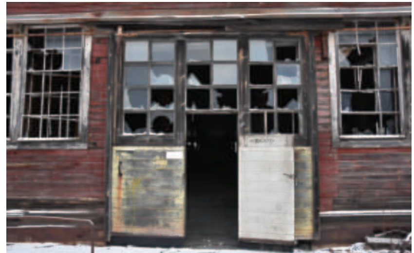
Seinä on rankorakenteinen. Täytteenä on ollut alkujaan sahanpuru, mutta sitä on täydennetty myöhemmin mineraalivillalla.
