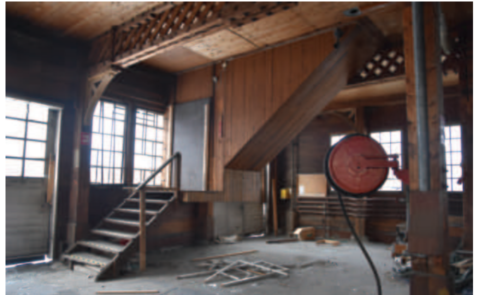
Yläkertaan johtava porras.
