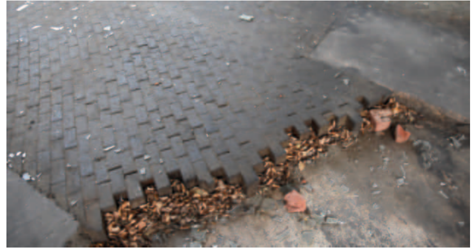
Ammattikoulun koneistusosaston pölkkyllattia. Hitsausuoneen ja pajan tilat oli erotettu ovilla.
