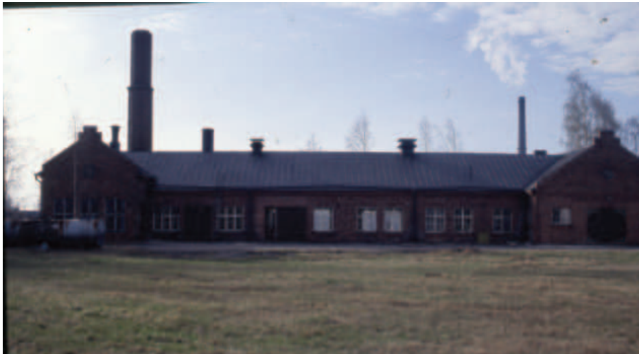
Taloussrakennus korjattuna 2.5.2000, Minna Linnala, SMK.
