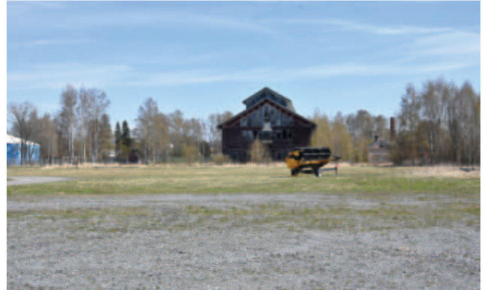
Lautatarhojen alue on rakentamatonta ja sieltä on purettu talotehtaan aikaiset varistorakennukset. Lautatarhoihin liittyvät kiskot on myös purettu.
