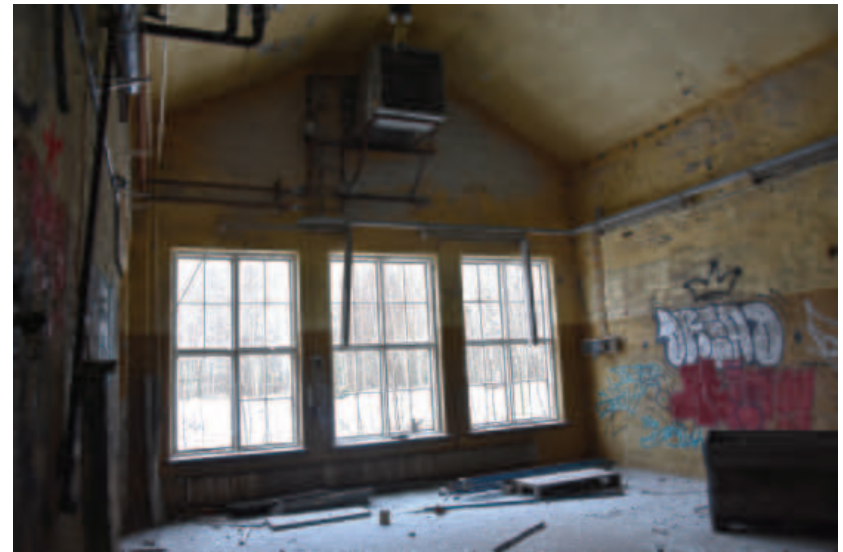
Kattilahuoneen seinä tielle päin. Tila toimi kattilahuoneena myös ammattikoulun aikana.
