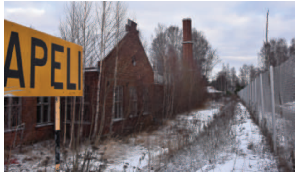
Sahan alue on aidattu korkealla panssariverkkoaidalla. Rakennusten vierellä vesikko on päässyt kasvamaan puustoksi.
