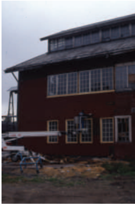
Saharakennuksen ikkunakorjaus käynnissä 10.8.1999, Liisa Nummelin, SMK.
