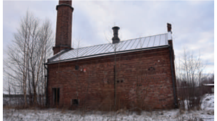
Taloustrakennuksen kattilahuoneen pääty.
