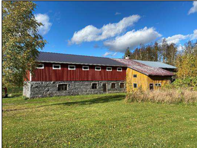
Osin kiinteistön 413-408-6-49 KALLIO alueella sijaitseva vanha navettarakennus.
