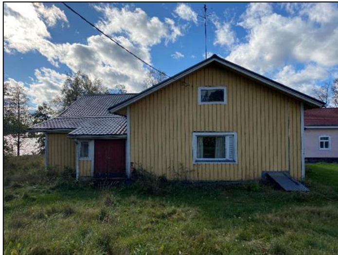
Asuinrakennus suunnittelun alueen kiinteistöllä 413-408-6-49 KALLIO. Alueelle on ranta-asemakaavassa tarkoitettu erillispientalojen rakennuspaikka.
