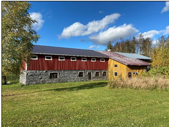
Osin kiinteistön 413-408-6-49 KALLIO alueella sijaitseva vanha navettarakennus.
