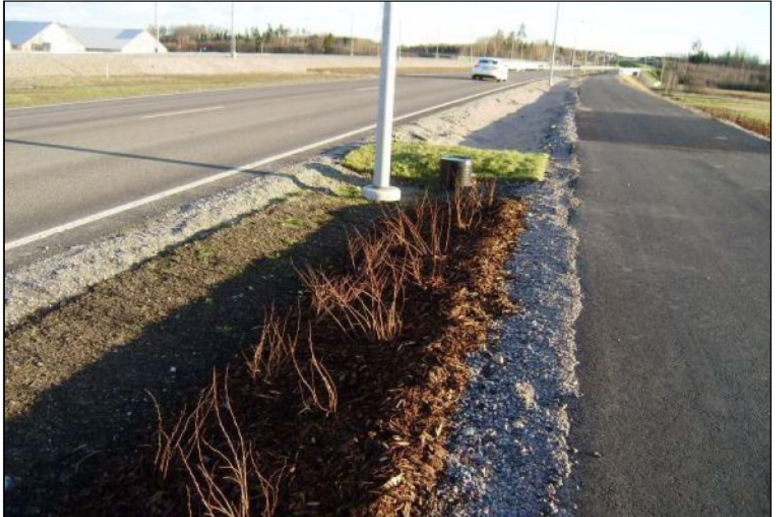
Kuva 7. Pääkadun vesien biosuodatus (Jormola, SYKE)
