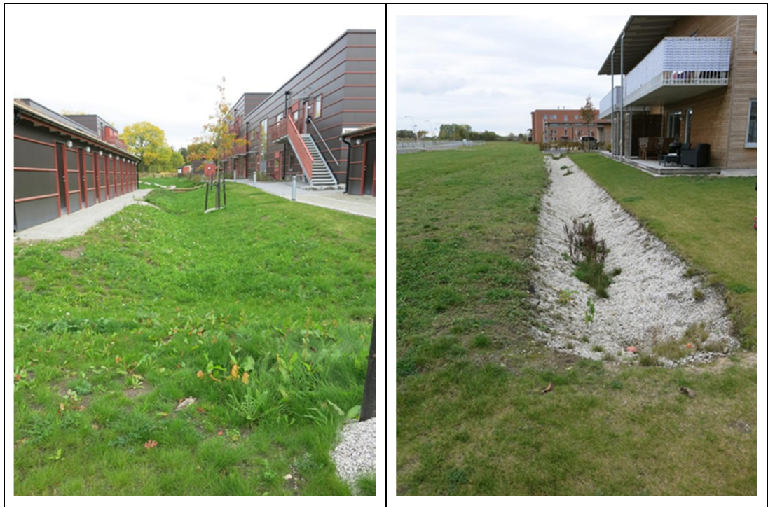
Kuva 9. Esimerkkejä hulevesiä viivyttävistä ja hidastavista johtamisrakenteista (Pöyry)
