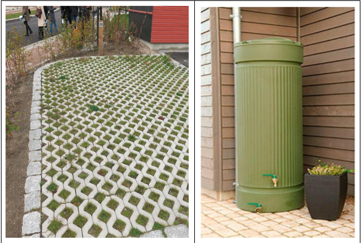
Kuvat 5. Esimerkki vettä läpäisevästä päällysteestä (Pöry) ja hyötykäytösäiliöstä (Vesita)
