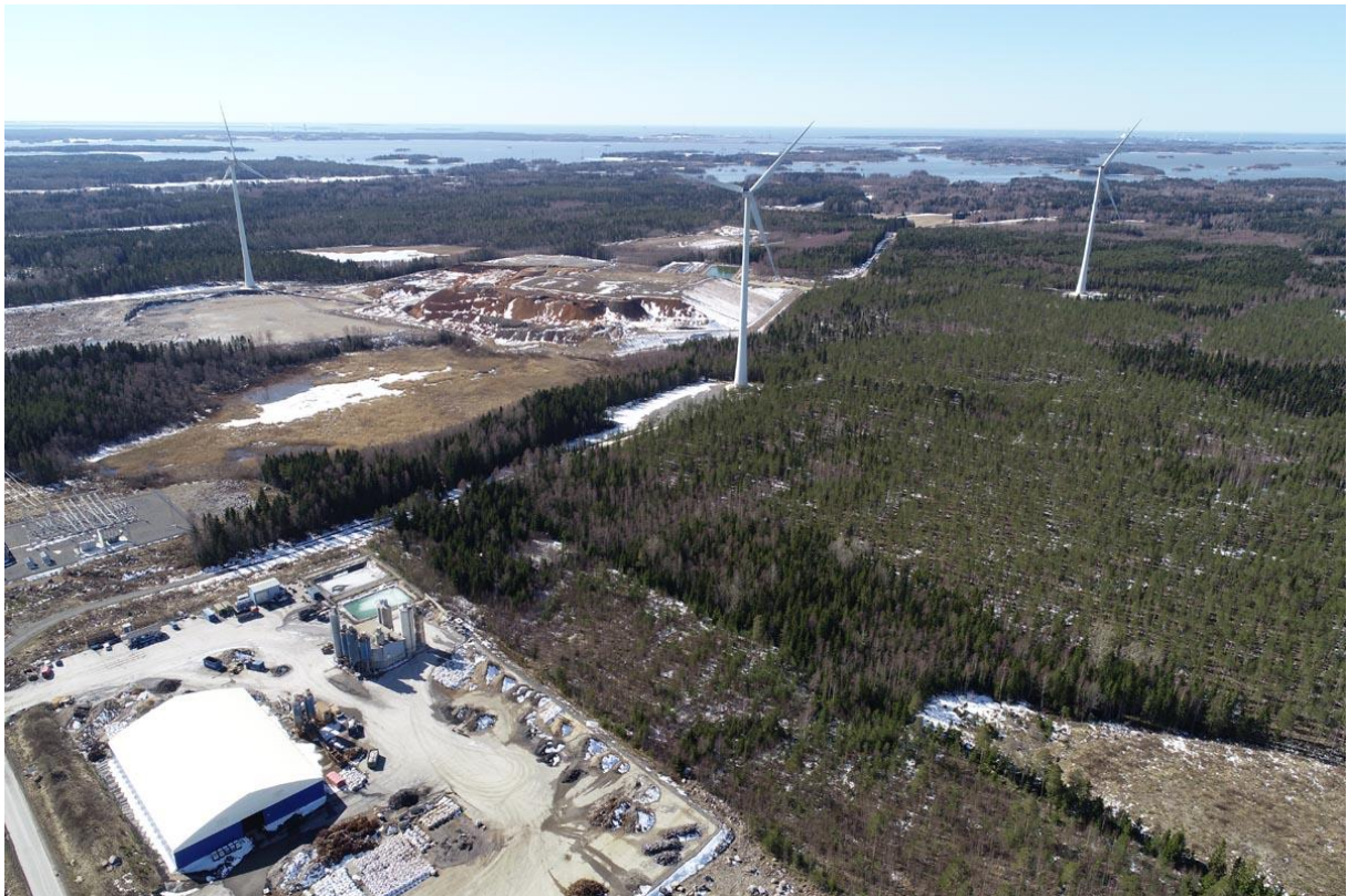
Fortum Waste Solutions:n laitos, sähköasema, Kuivattujärvi.
