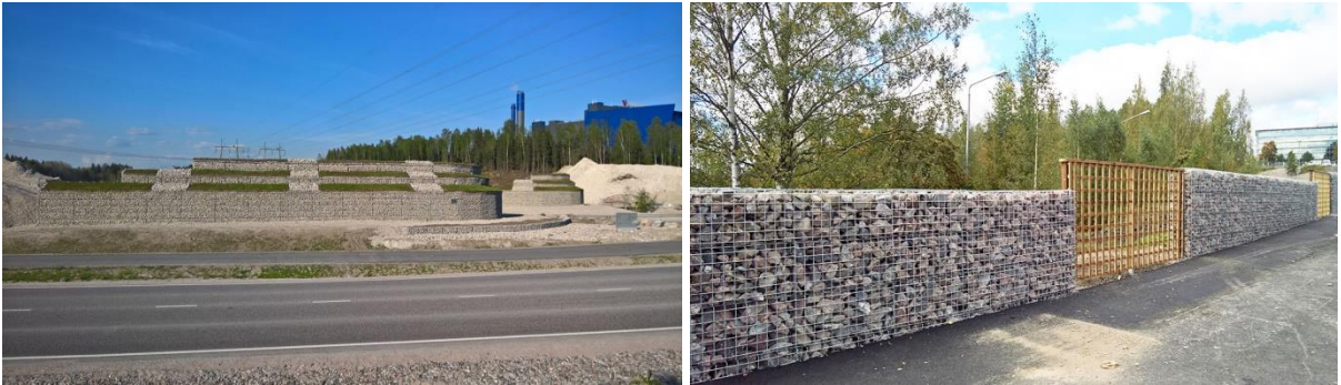
Kuva 3-21. Esimerkkejä meluseinäratkaisuista. (Lähde: yllä Versowood 2020, alla SSTec Oy 2020)
