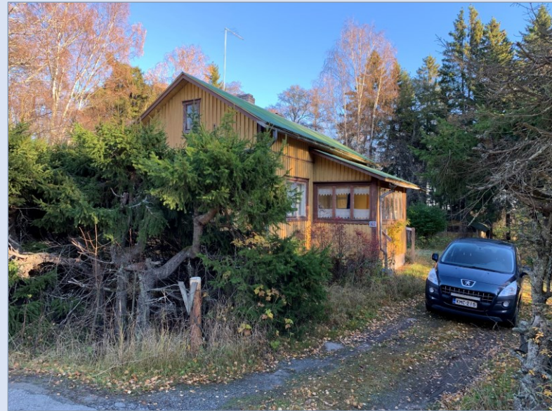
Asuinrakennus Reposaaren maantieltä.
