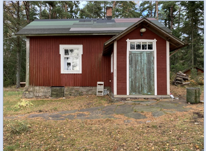
Rakennusta on kunnostettu säilyttävästi yksityiskohdat huomioiden.
