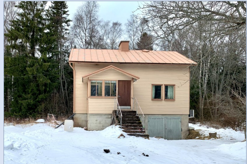
Reposaaren maantie 927 b:n lähes alkuperäisessä asussaan säilynyt asuinrakennus on arvoltaan luokkaan B.
