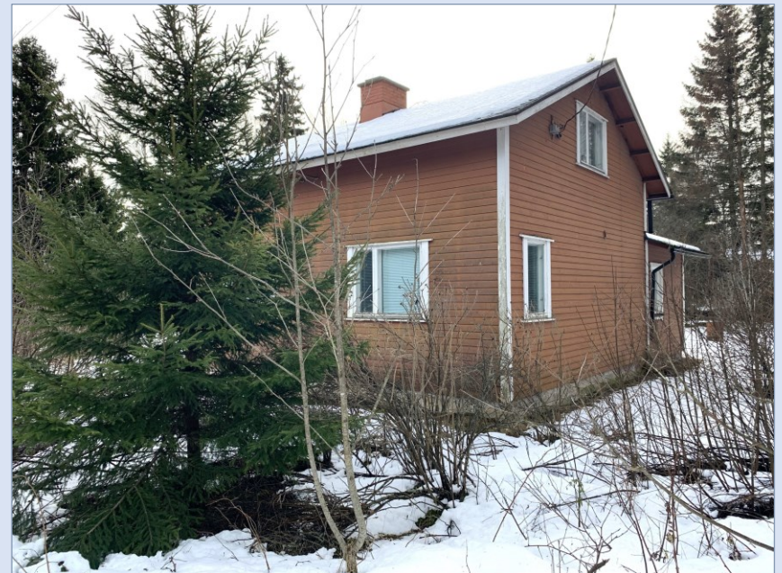
Jälleenrakennuskaudelle tyypillinen asuinrakennus Reposaarentie 10:ssä.
