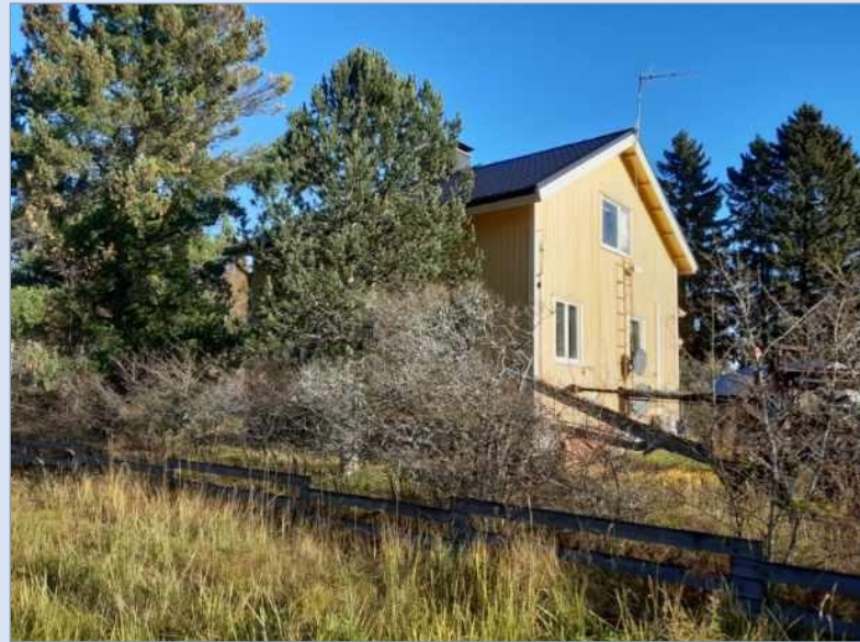
Asuinrakennus Reposaaren maantieltä.
