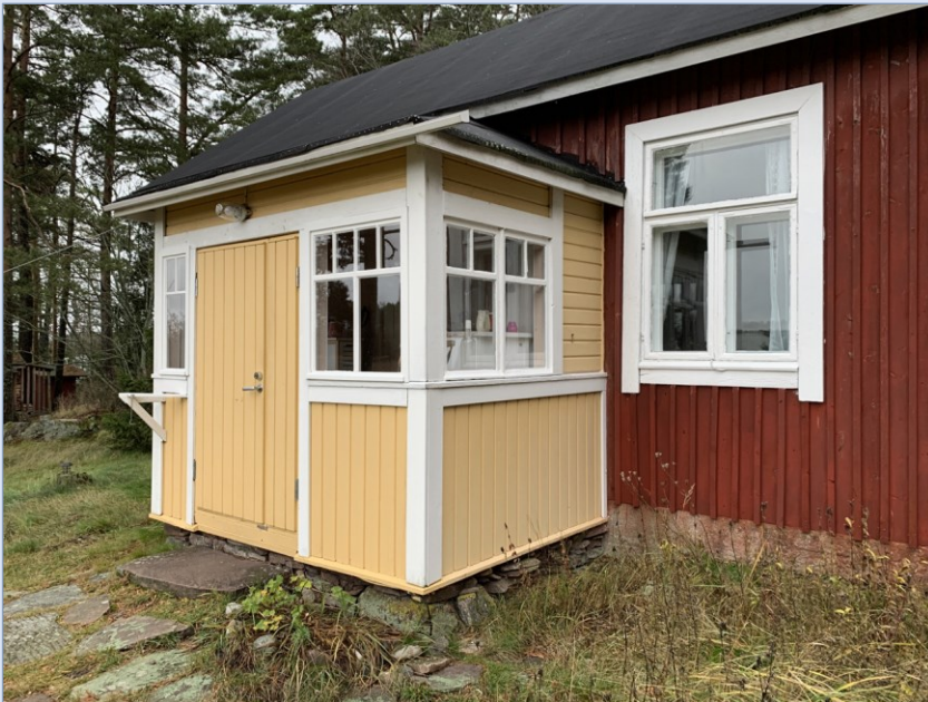
Puuikkunat on kunnostettu ja kuisti maalattu.
