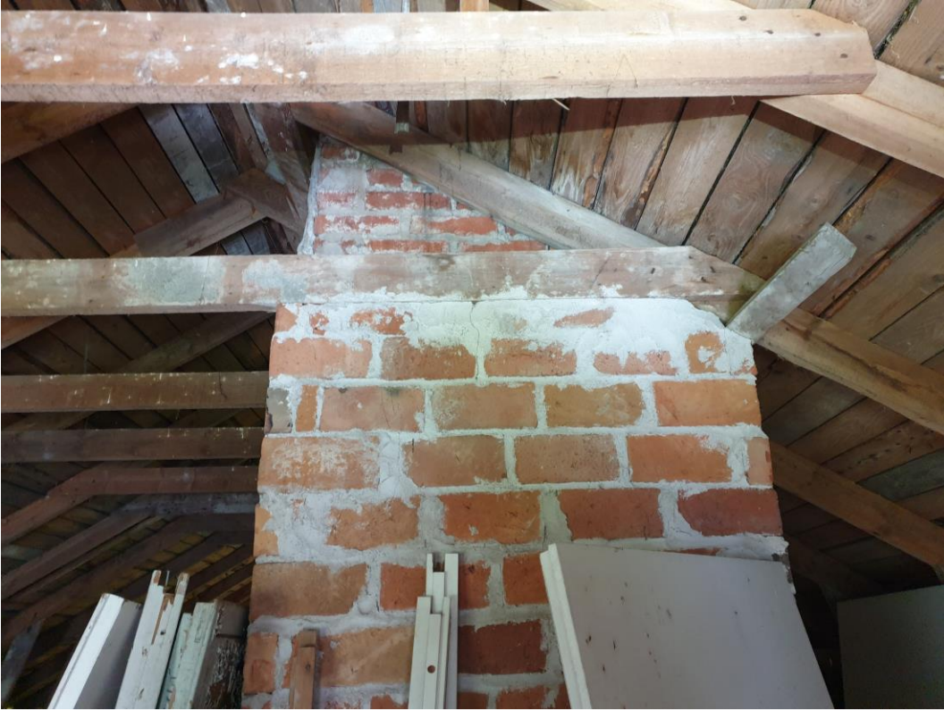
Ulkorakennuksen muuria sisältä.
