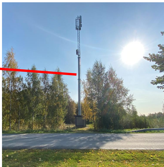
Kuva 10. Antennipylväs sijaitsee Yrttitien ja Lattomerenojan välittömässä läheisyydessä. TB
