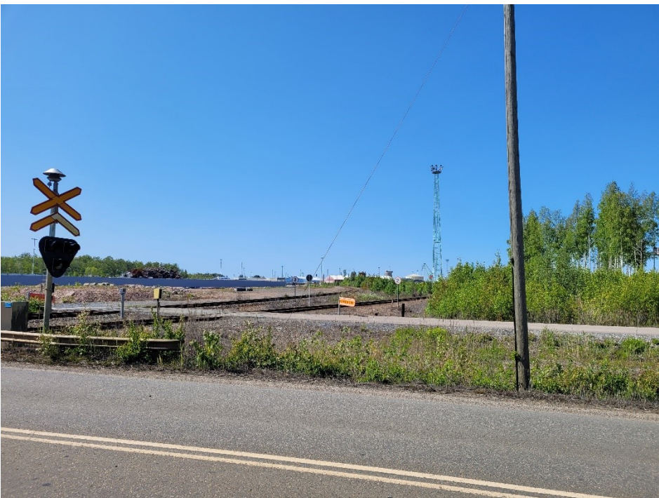
Kuva 37. Näkymä kaava-alueen luoteispuolelta Kirrinsannantieltä länteen (Sweco 2023).
