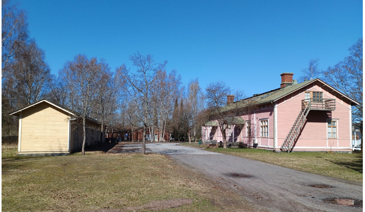
Kuva 2. Suunnittelualueella olevat Porin vanhaan asemakylään kuuluvat rakennukset.
