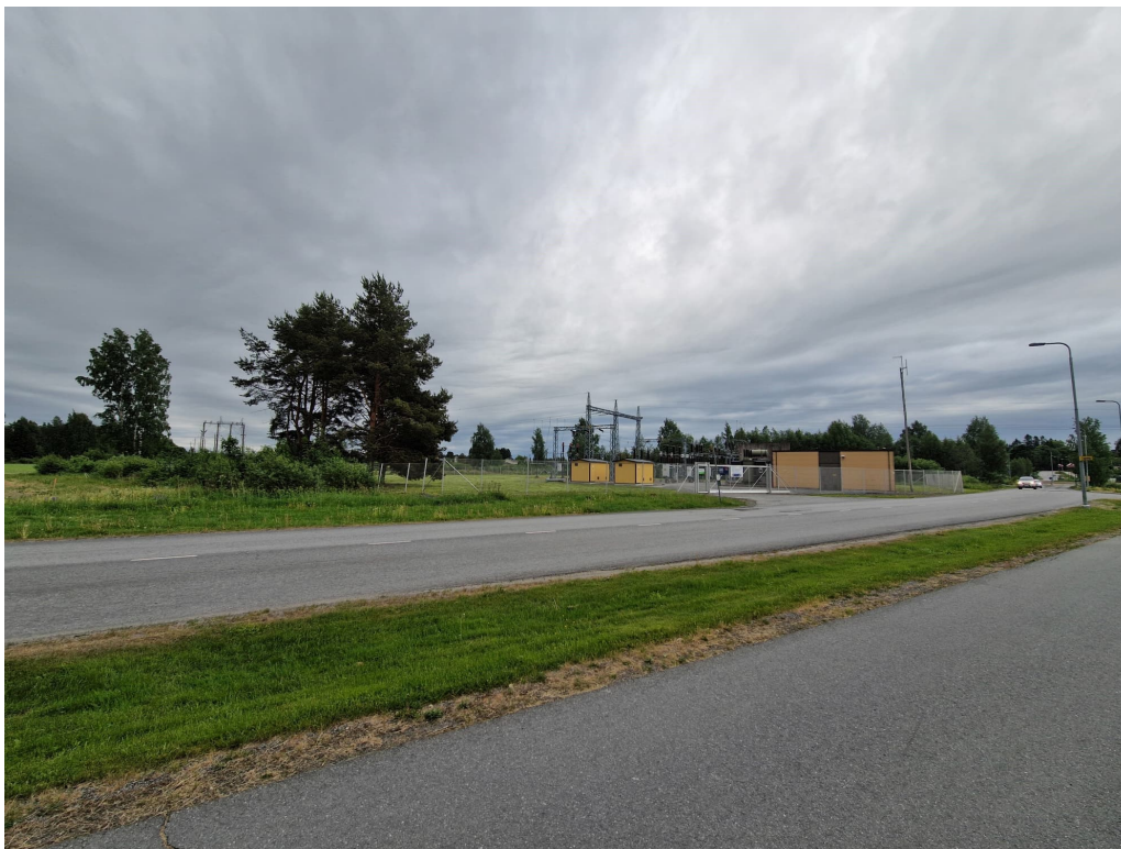
Kuva 2 Sähköasema kuvattuna pohjoisesta. (©Tia Koponen, 6.6.2024)
