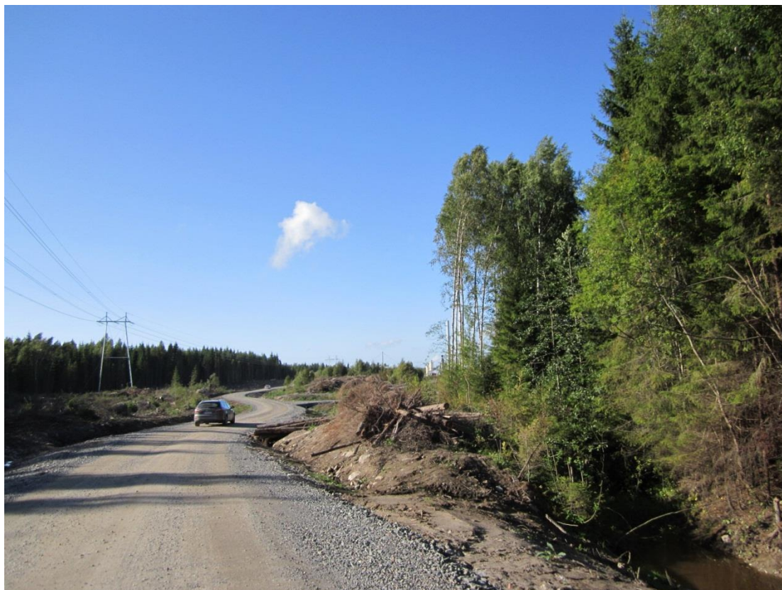
Kuva 85. Kuvassa tyypillinen tuulivoimalalle johtava huoltotie.
