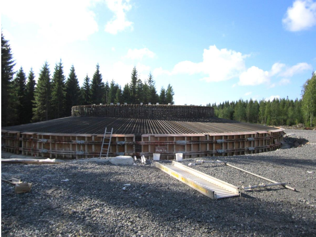
Kuva 84. Kuvassa esimerkki tuulivoimalan perustusten rakentamisesta).
