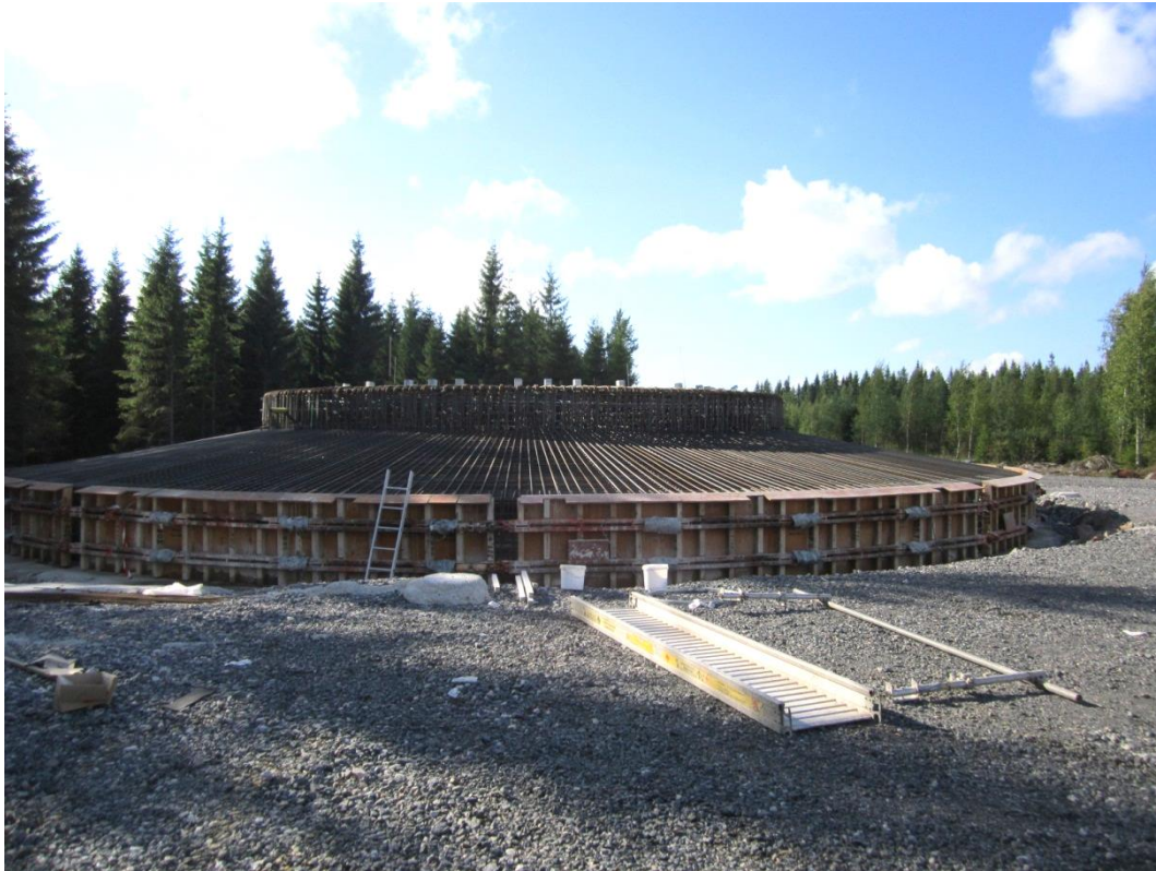
Kuva 84. Kuvassa esimerkki tuulivoimalan perustusten rakentamisesta).
