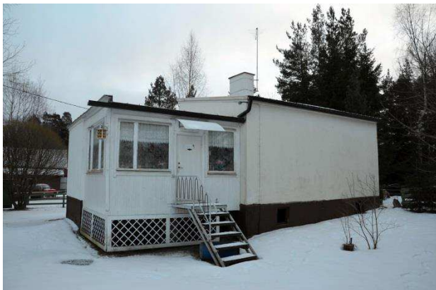
Kuvat: Linnainmaan kesäasunnon funkkisdetaljeja: eteläpuolen nurkkaikkuna, katos, ulko-ovi ja ikkunoiden metalliset räystäälistat.
