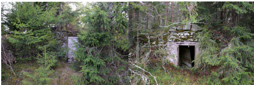
Kuva: Jos tontilta ei löytynyt sopivaa kellarinpaikkaa, oli se mahdollista rakentaa torpan/tilan maille. Vasemmalla Pekkalan, vanhan sorakuopan penkereeseen kaivettu maakellari. Oikealla Järvensivun kellari alueen luoteispäässä. Kivi- ja betonirakenteiset kellarit ovat 1900-luvun alkupuolelta.
