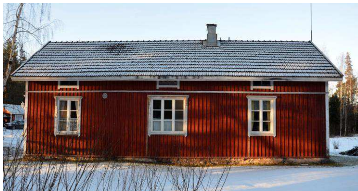
Kuva: asuinrakennuksen itäjulkisivu
