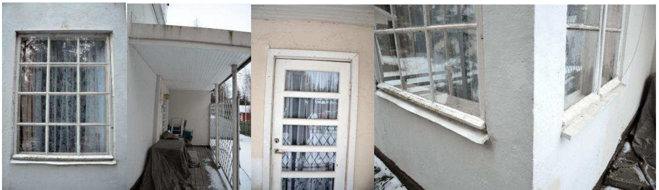
Kuvat: Linnainmaan kesäasunnon funkkisdetaljeja: eteläpuolen nurkkaikkuna, katos, ulko-ovi ja ikkunoiden metalliset räystäälistat.
