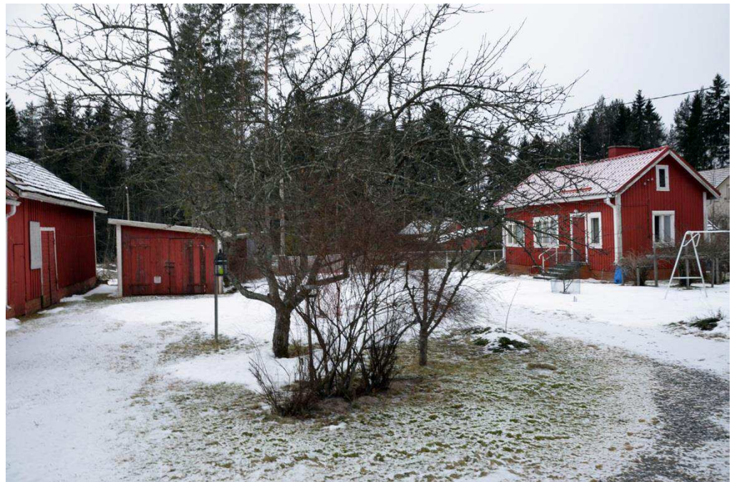
Kuva: Varjolan talousrakennuksia, rakennukset 2,3 ja 4.
