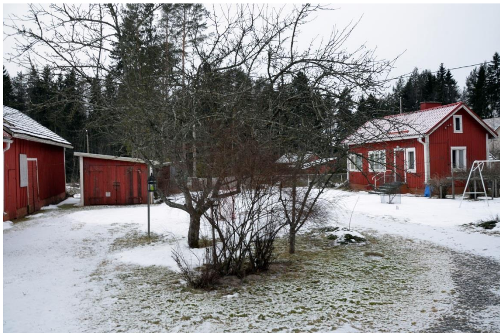
Kuva: Varjolan talousrakennuksia, rakennukset 2,3 ja 4.
