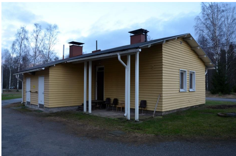
Kuvat: Saunarakennuksen alkuperäinen piirustus ja rakennus lounaasta. 1984 rakennettu wc-siipi näkyy rakennuksen vasemmassa reunassa.
