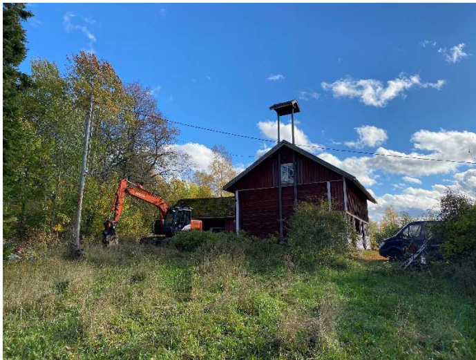
Maatilan talousrakennus kiinteistön 413-408-6-49 alueella.
