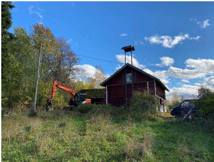
Maatilan talousrakennus kiinteistön 413-408-6-49 alueella.
