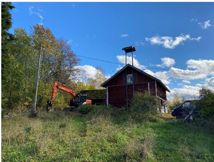
Maatilan talousrakennus kiinteistön 413-408-6-49 alueella.
