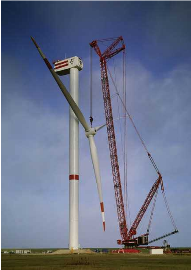
Kuva 3-11. Tuulivoimalan pystytys tela-alustaisella nosturilla (Liebherr).
