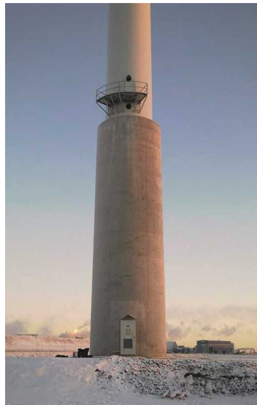
Kuva 3-5. Hybriditorni, Tornio (Ramboll Finland Oy).
