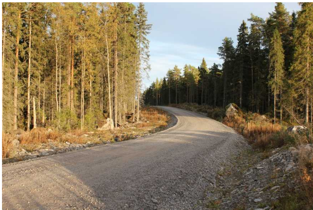
Kuva 3-8. Tuulivoimalan huoltotie – Ojen, Vaasa (Ramboll Finland Oy).
