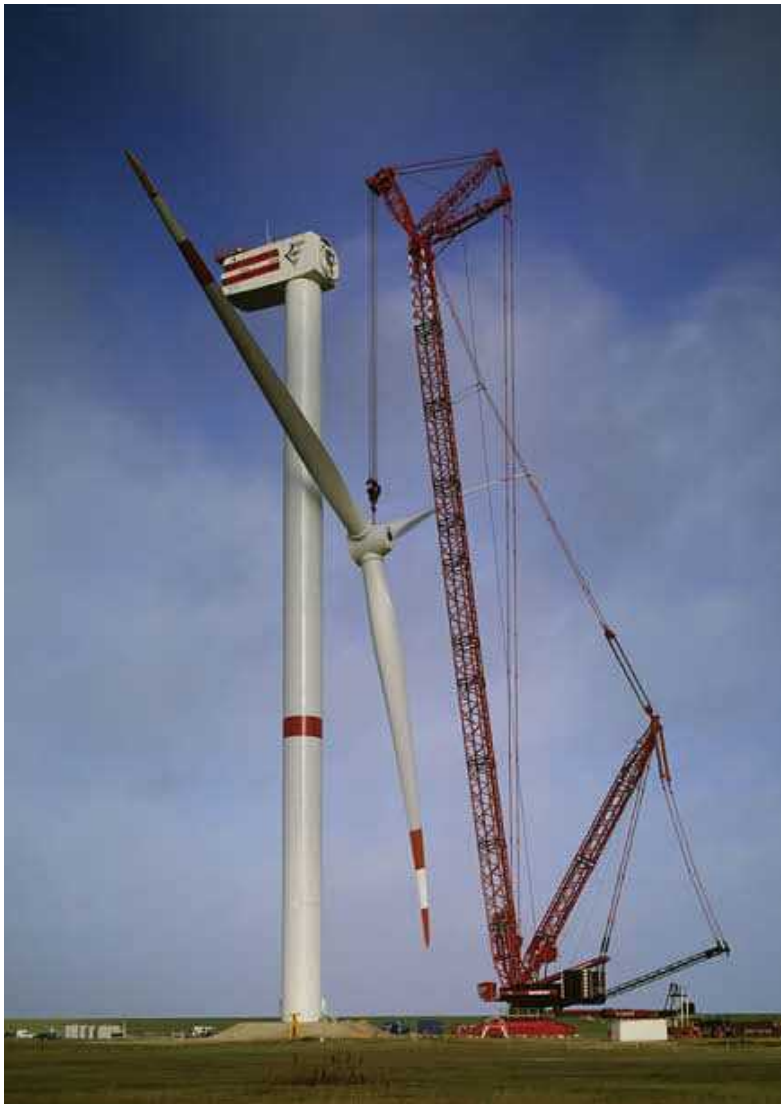
Kuva 3-11. Tuulivoimalan pystytys tela-alustaisella nosturilla (Liebherr).
