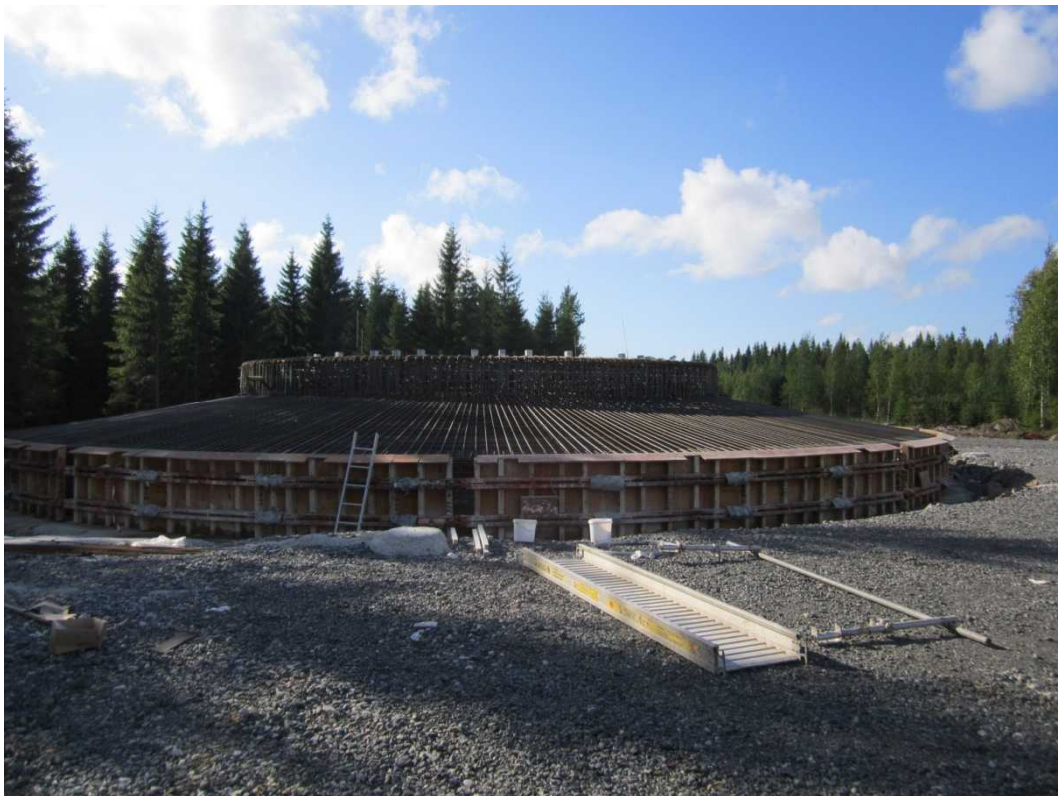
Kuva 7-4 Kuvassa esimerkki tuulivoimalan perustusten rakentamisesta
