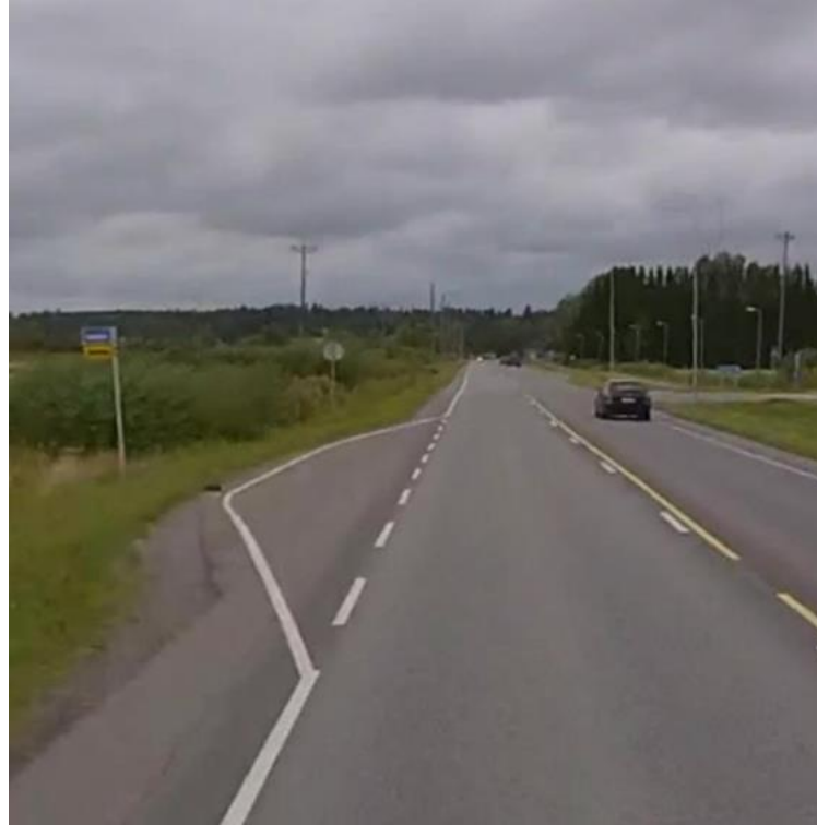
Paikallis- ja kaukoliikenteen pysäkkilevennys Vaasantiellä Hyvelänraitin liittymän eteläpuolella. Kuvassa Hyvelänraitti alkaa tumman auton kohdalta oikealle. Kuva: Google Maps.
