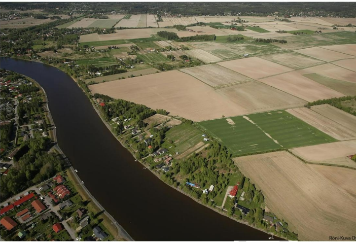
Kuva 14: Näkymä kääntöuoman paikalle lounaasta 2017. Röni-kuva oy.
