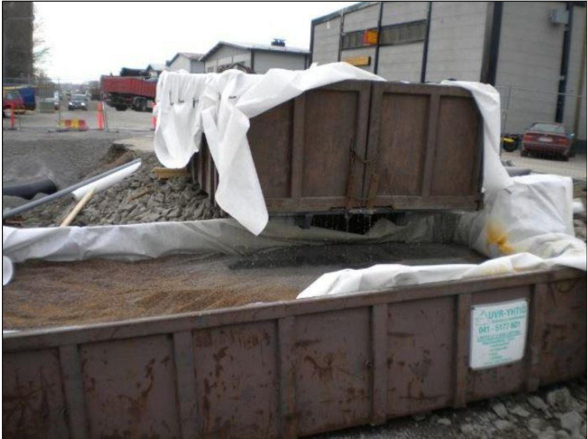
Kuva 11. Esimerkkikuva vaihtolavan sisään rakennetusta suodattimesta. 3
