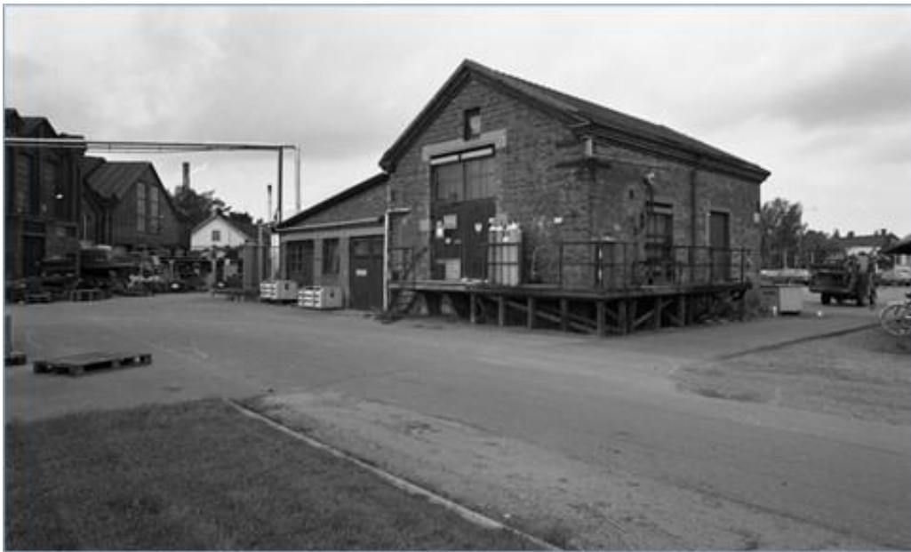
Kuva 10. Polttoainevarasto kaakosta. Kuva Jalo Porkkala 1985, Satakunnan Museon kokoelmat. Porin Konepajan ja Isosannan sahan rakennusinventointi (Porin kaupunkisuunnittelu 2022).
