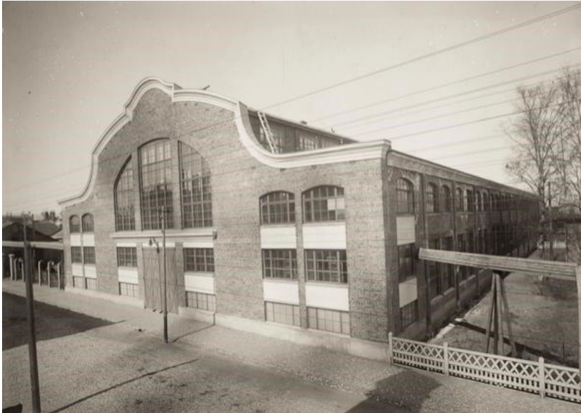
Kuva 15. Vuonna 1917 valmistunut viilaverstas. Kuva Rosenlew-museon kokoelmat. Porin Konepajan ja Isosannan sahan rakennusinventointi (Porin kaupunkisuunnittelu 2022).
