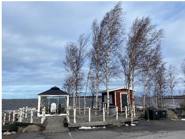
Kuva 6: Cafe Kallon rakennuksia kaava-alueen pohjoisosassa.
