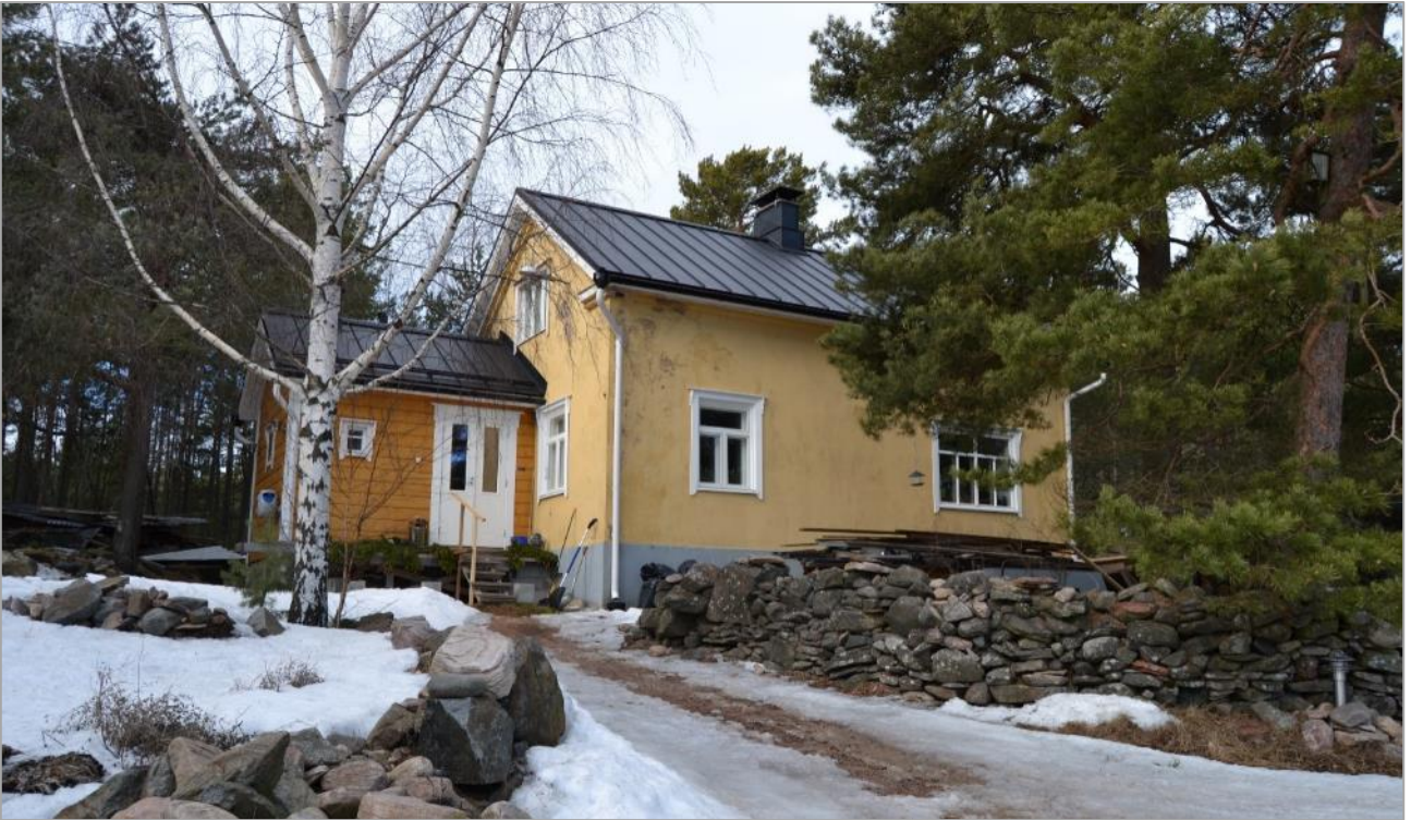
Kuva 47. Entinen öljysatamanhoitajan asuinrakennus maaliskuussa 2022. Kuvannut KT.
