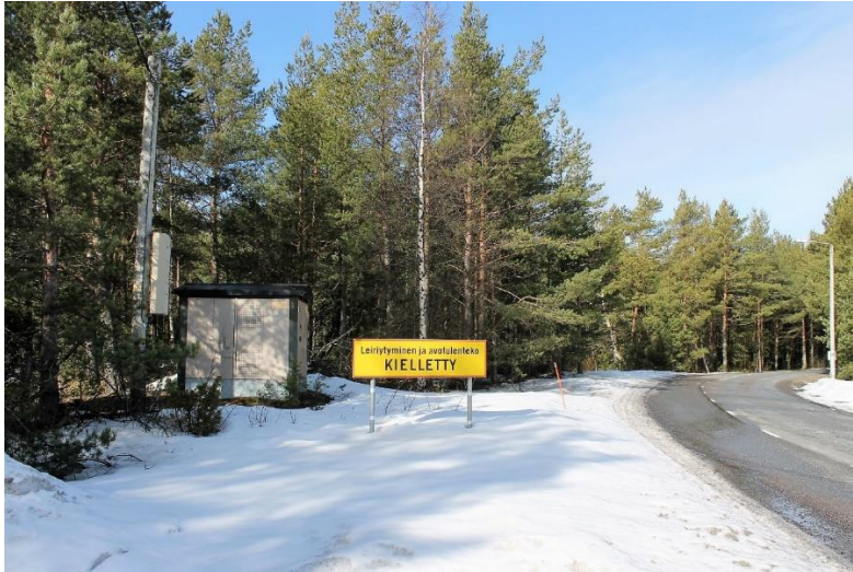
Kuva 14. Muuntamorakennus sijaitsee sisääntulotien läheisyydessä epävirallisen parkkipaikan reunalla.
