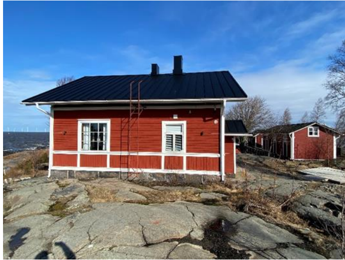
Kuva 18: Luotsivartiotupa sekä pihapiiriin kuuluvia talousrakennuksia.
