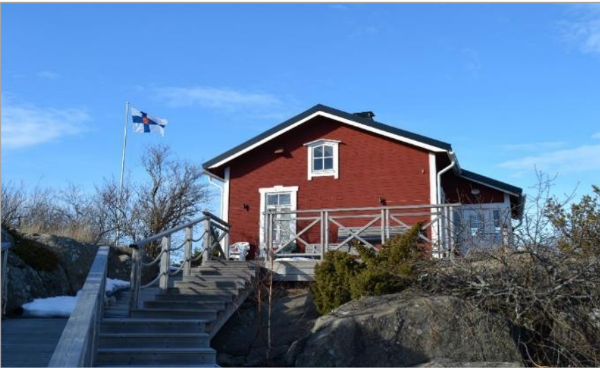
Kuva 37. Luotsivartiotuvan eteläinen pääty. Kuvannut KT.
