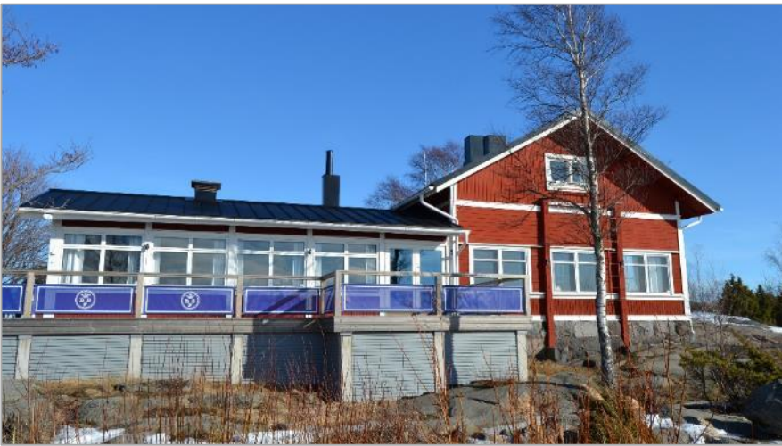
Kuva 28. Paviljongirakennus kuvattuna meren puolelta. Laajennusosan edustalla on betonipaalujaan varaan perustettu terassi. Kuvannut KT.
