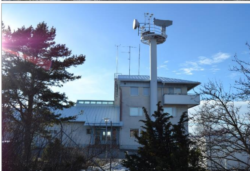
Kuva 43. Merivartioaseman alkuperäinen rakennusosa idästä. Matalamman rakennusosan katon harjalla on kattolyhty. Kuvannut KT.
