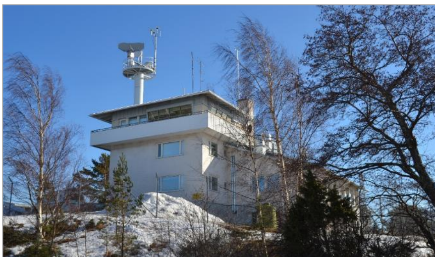
Kuva 41. Merivartioaseman pohjoispääty. Ylimmän kerroksen valvomon ikkunat ovat ulospäin kaltevat. Valvomoa kiertää profiilipeltiparveke. Kuvannut KT.
