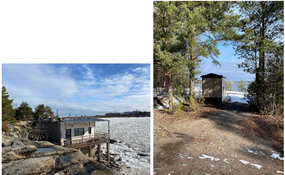
Kuvat 16 ja 17: Kuvassa 16 entisen öljysataman korjattu rakennus ja kuvassa 17 kaava-alueen eteläosassa Kallontien varrella sijaitseva sähkömuuntamo.
