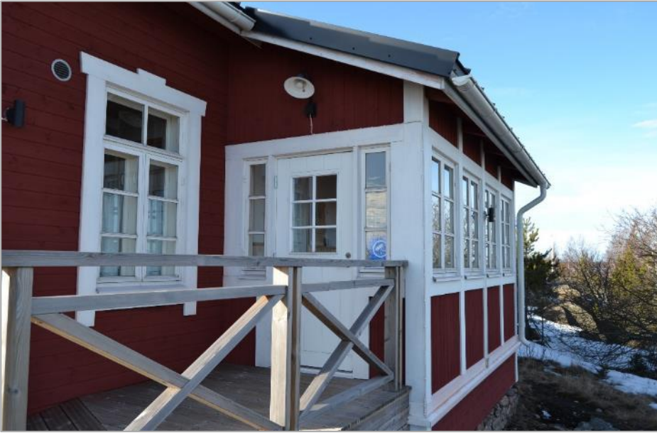
Kuva 38. Luotsivartiotuvan itäsivulla sijaitsee kuisti. Kuvannut KT.
