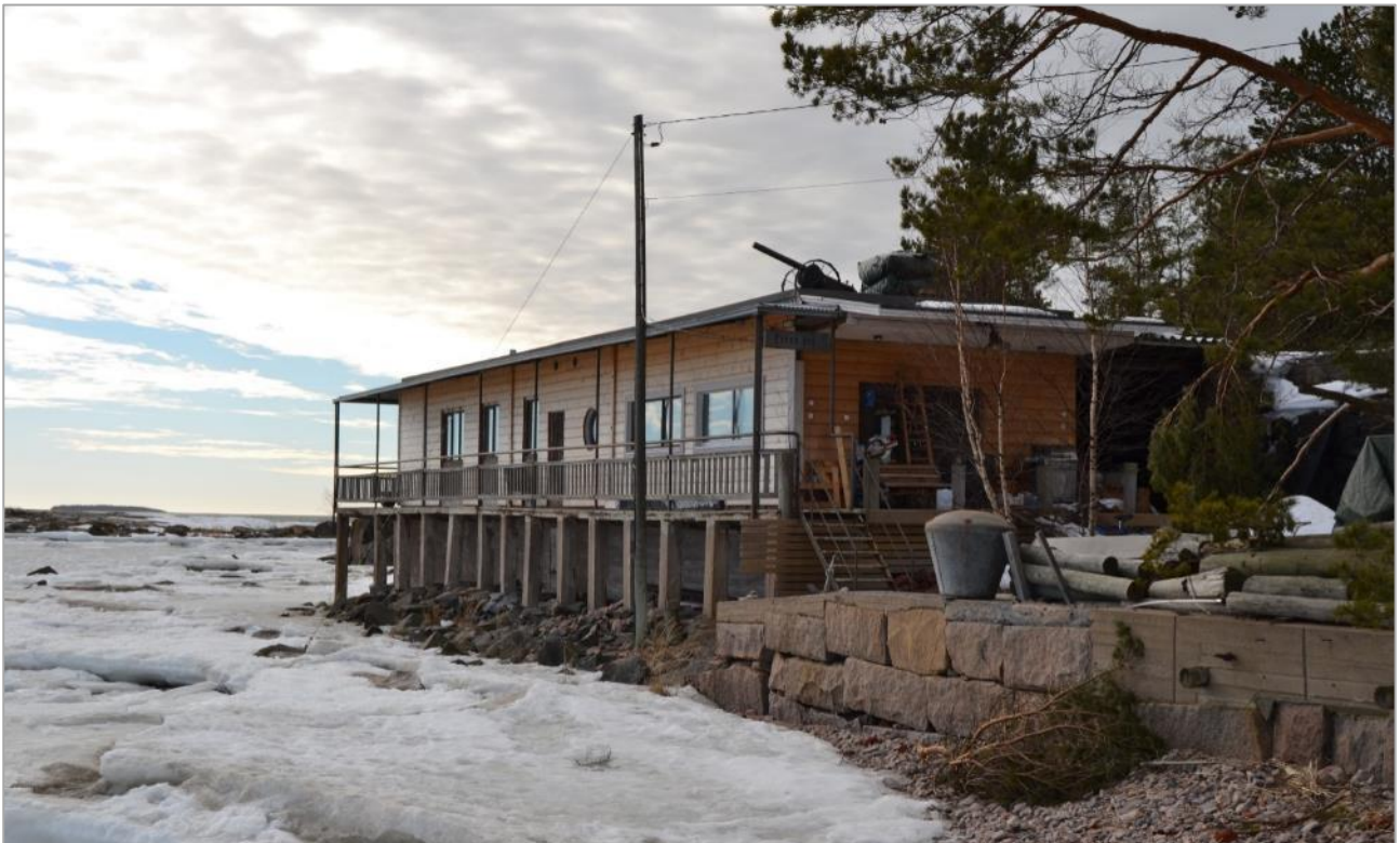
Kuva 46. Entisen öljysataman rakennus Mäntykallon etelärannalla. Kuvannut KT.
